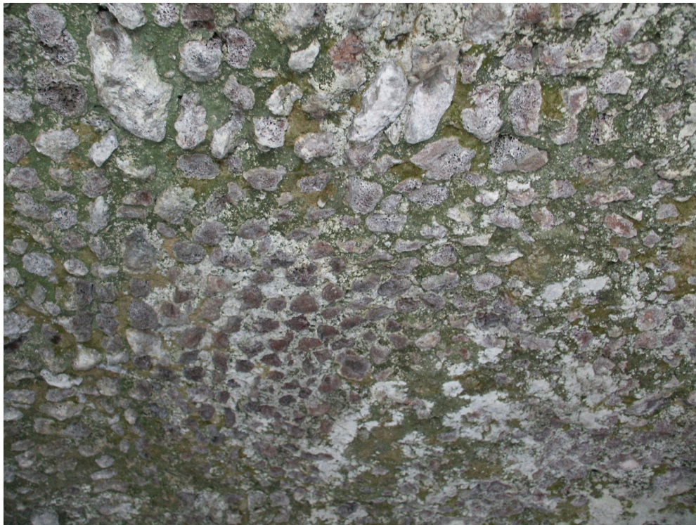
Particolare delle volte di getto di una casa fortificata a Somma Vesuviana.
