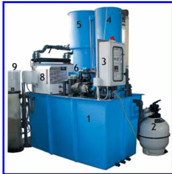
FIGURA 4.4. IMPIANTO DI FILTRAZIONE CON VASCA DI POLMONE.
