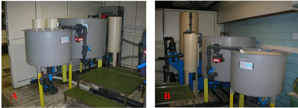
**Figura 7.** Lato sinistro (A) e destro (B) dell'impianto pilota a circuito chiuso per l'allevamento di copepodi Calanoidi.
