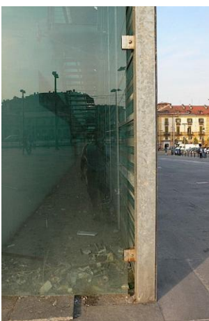
Intercapedine interna dall'esterno
