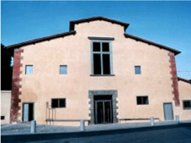
Facciata principale dopo il restauro. Scuderie della Villa di Poggio a Caiano. Arch. F. Purini.
