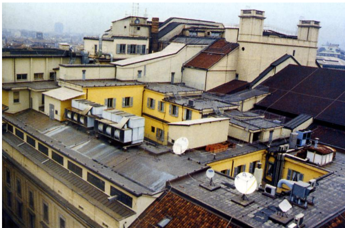
Immagine dei sovratetti su via Filodrammatici prima dei lavori
