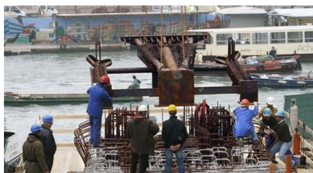
Lato Stazione, Venezia - Inserimento _Zoccolo_ fondazione
