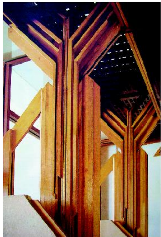
Foto stato attuale. Restauro di Cà Foscari, Arch. C. Scarpa (1955-1956))
