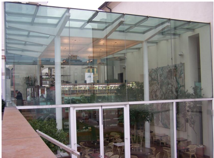
Lato verso il coffeehouse. Mediateca. Arch. M2P Architetti Associati
