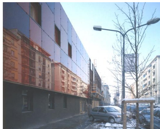
Gruppo 5+1 per la Ristrutturazione dei Frigoriferi.
