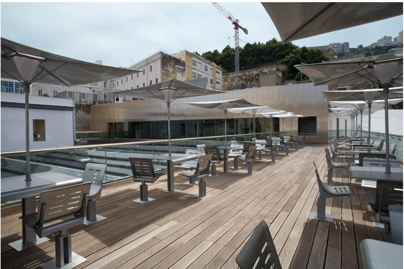
Terrazza di copertura
