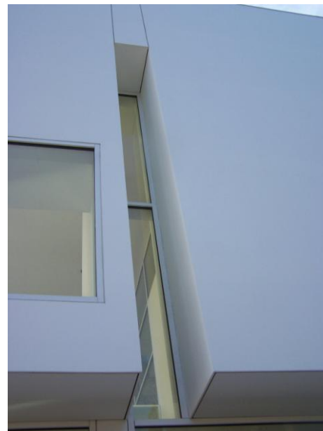
Feritoia di luce lungo il prospetto.
