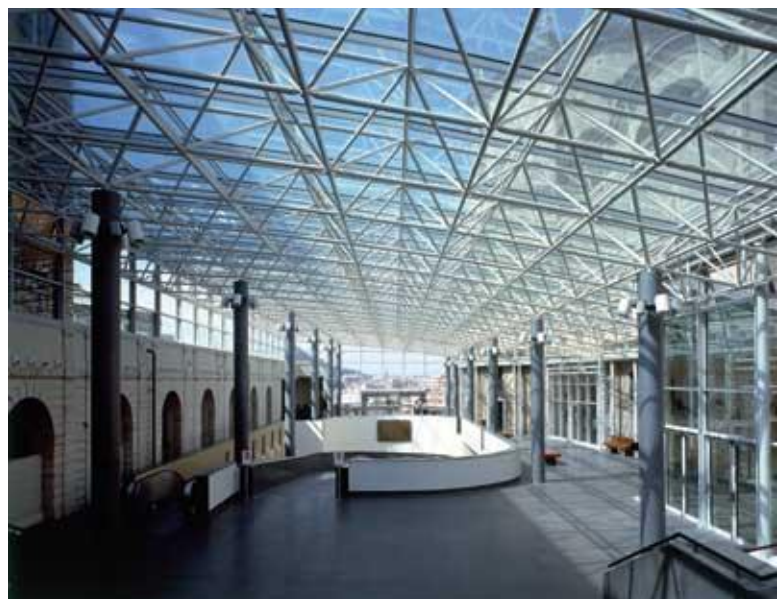
Terrazza e copertura vetrata. Studio Passarelli.
