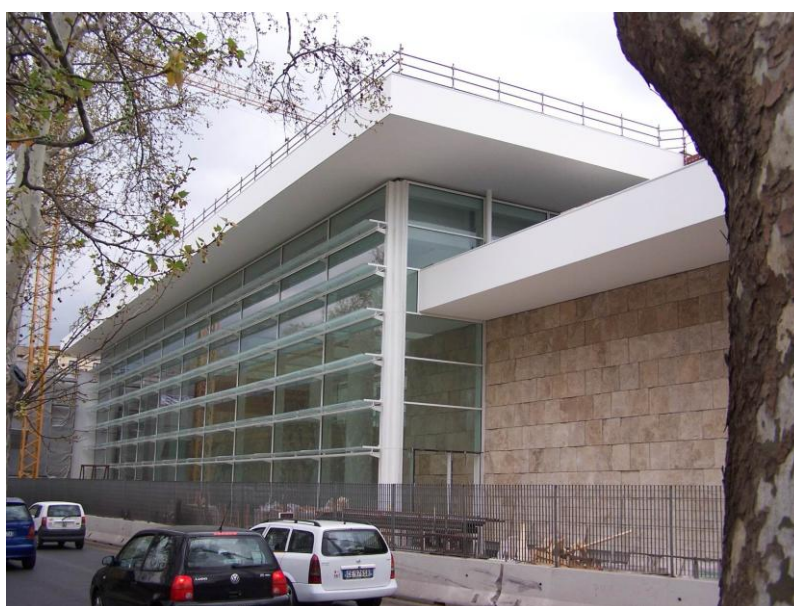
Prospetto vetrato verso il Lungotevere.
