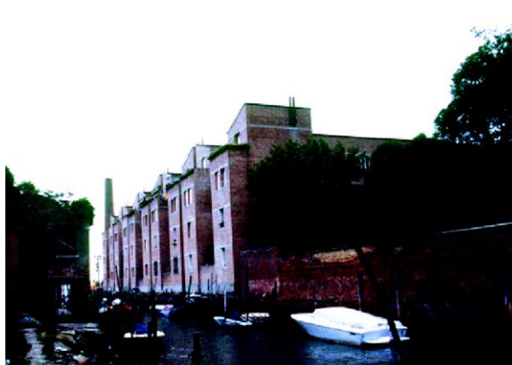
Veduta del complesso di abitazioni di Gino Valle
