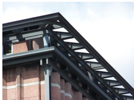
Particolare del tetto di copertura.
