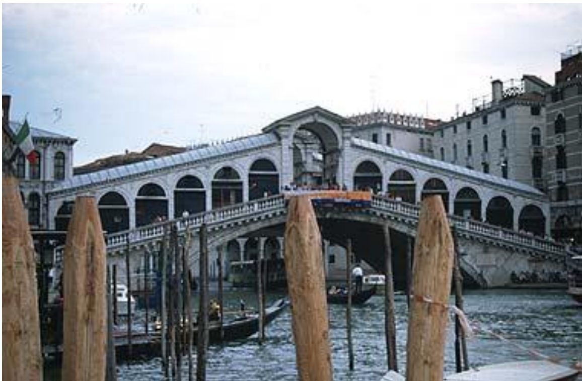
Ponte di Rialto
