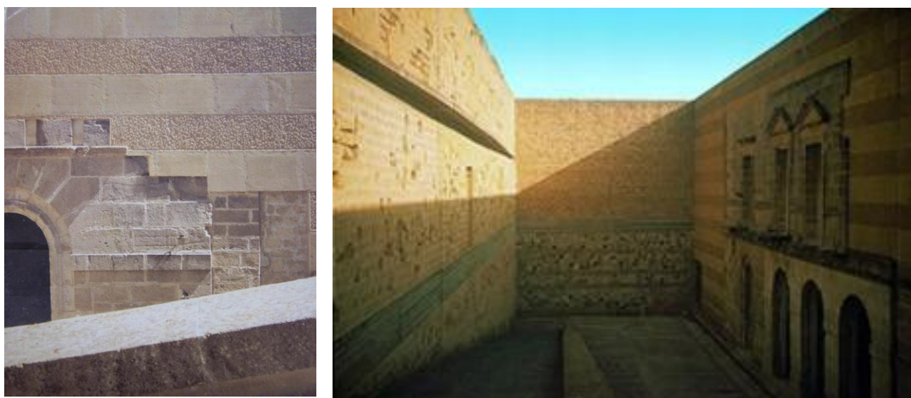
Particolare trattamento del prospetto di Ghibellina. Arch. F. Venezia. Interno del Museo di Ghibellina, Arch. F. Venezia.
