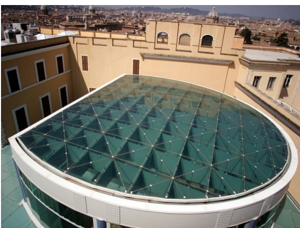
Particolare copertura vetrata.
