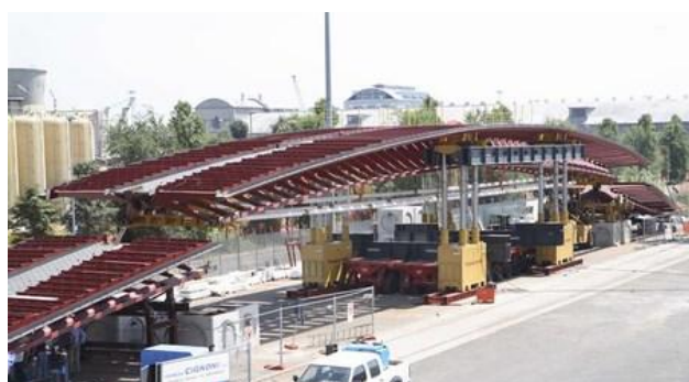
Prova di sollevamento
