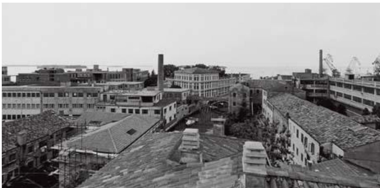
L'area con gli edifici industriali dismessi della Junghans prima dell'intervento.
