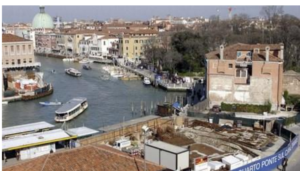
Venezia- Allestimento cantieri
