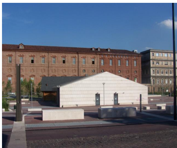
Uscita parcheggio. Piazza Valdo Fusi. Arch. M.Crotti, F. Dolza, M. P. Forzans, M. Marcelli
