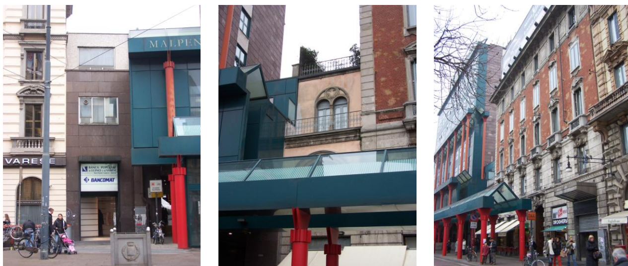
Particolari del fronte stazione con il tessuto urbano.
