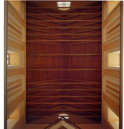
Copertura in legno. interna Chiesa dei SS. Filippo e Giacomo, Ospedaletto d'Alpinolo, 1987. Arch. R. Dalisi
