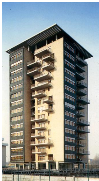
Massimiliano Fuksas per le Torri residenziali nell'Area OM
