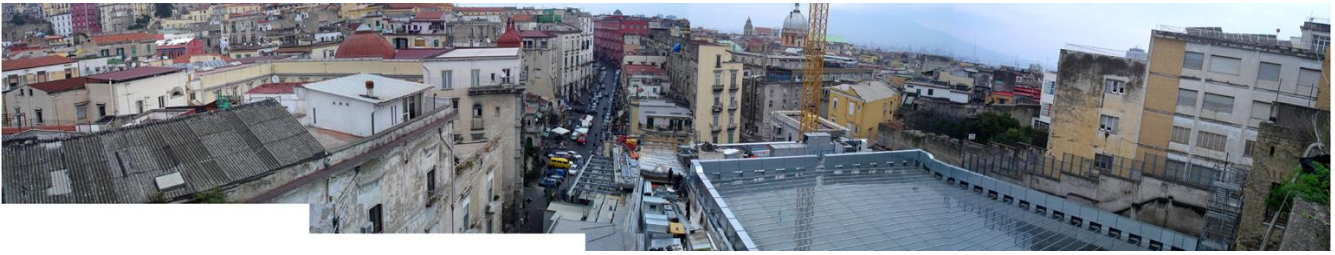
Quadro d'unione immagini . Vista dalla copertura della Stazione di Montesanto verso il quartiere.
