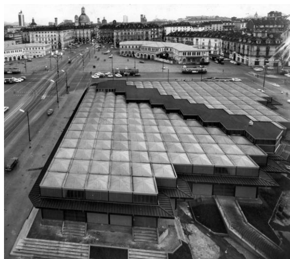
La copertura dell'ex mercato dell'abbigliamento
