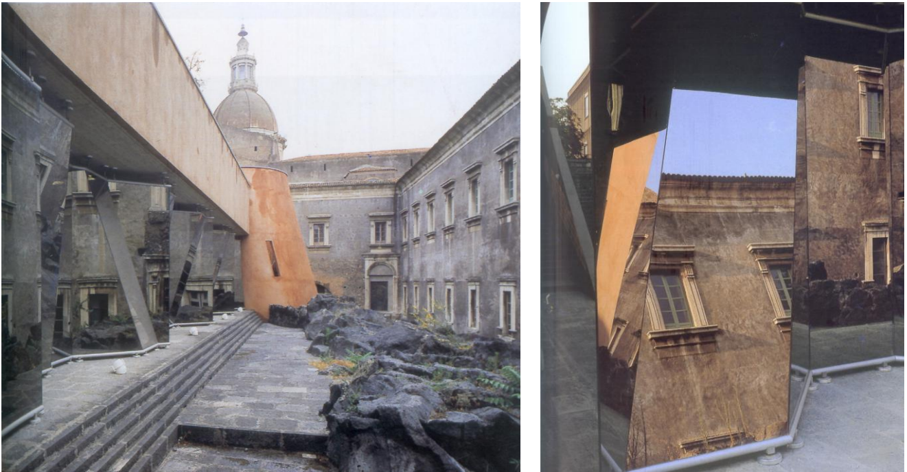
Recupero ex Monastero dei Benedettini a Catania, nella Facoltà di Lettere e Filosofia. Arch. G. De Carlo Particolare facciata in vetro. Arch. G. De Carlo
