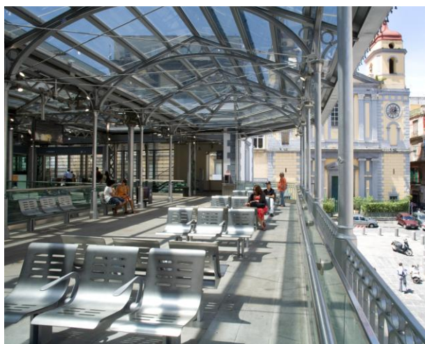
Spazi interni della pensilina liberty
