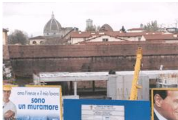
Fortezza da Basso, progetto di parcheggio sotterraneo nel piazzale Caduti dei Lager. Veduta della parte est del cantiere con lo sfondo della cupola di S. M. del Fiore. I volumi in bianco sono della struttura in costruzione che ospiterà gli esercizi commerciali con una sopraelevazione di almeno 3 mt sopra i bastioni del Sangallo
