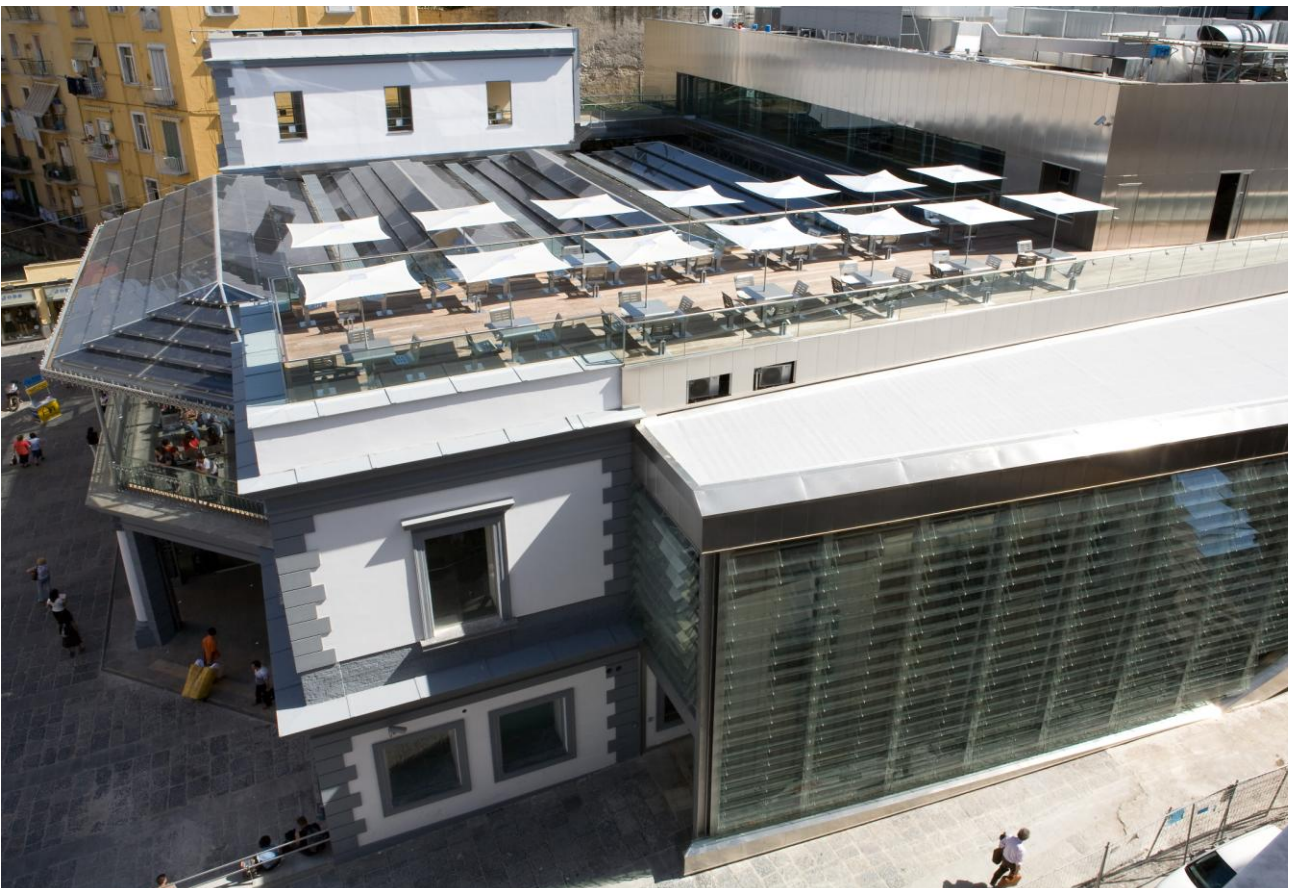
Foto della stazione dall'alto, in cui è visibile la terrazz-bar
