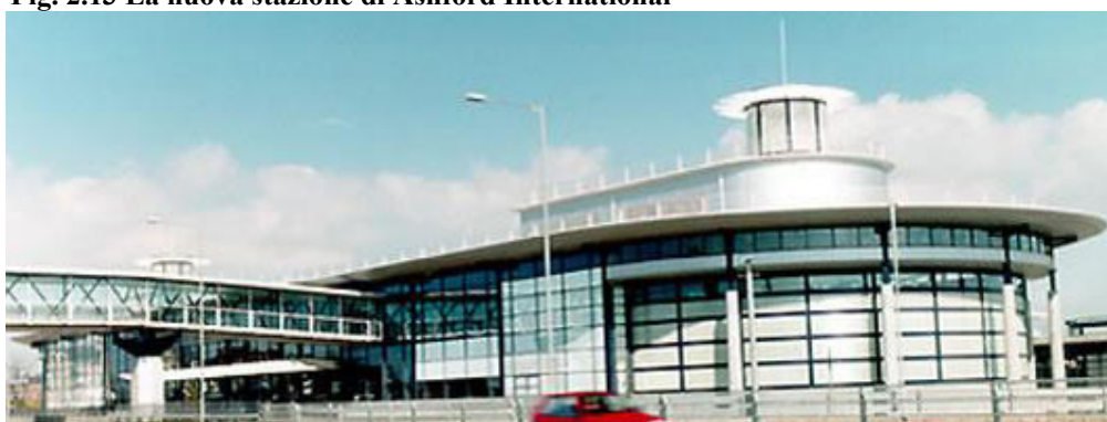
Fig. 2.13 La nuova stazione di Ashford International
