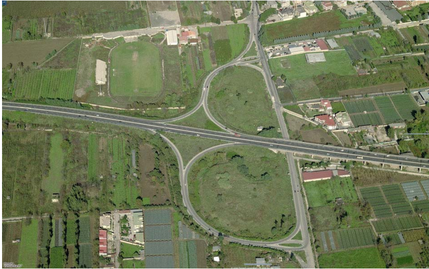
Lo svincolo sulla SS162
