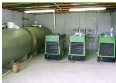
Figura 4.15. Locale di servizio: serbatoi di stoccaggio acqua di mare, soffianti, gruppi elettrogeni
