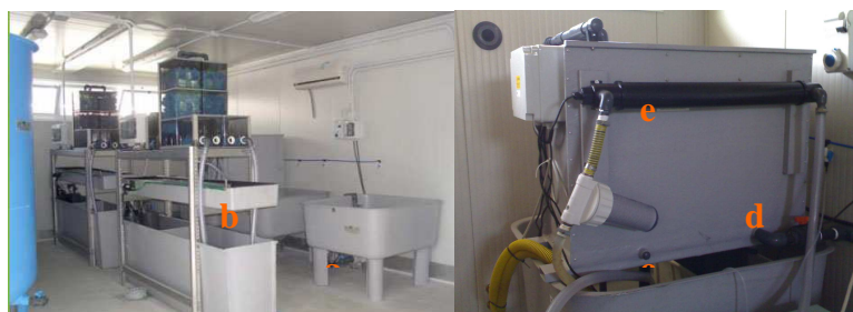
Figura 4.18. Reparto molluschi bivalvi: adattamento e maturazione riproduttori (a); schiuditoio (b); modulo per il trattamento meccanico (filtro a cartuccia) (c), biologico (percolatore) (d) e sterilizzante (U.V.) (e) dei riproduttori
