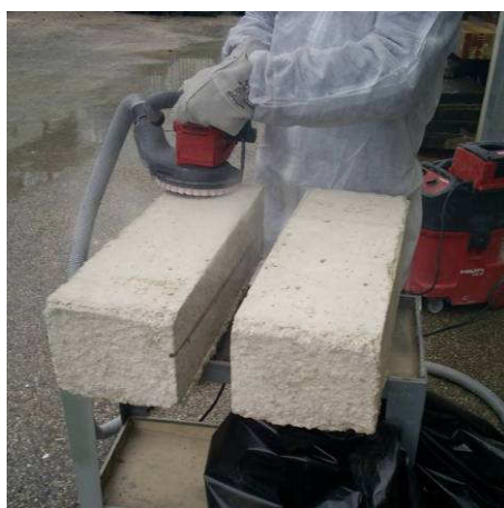
Fasi della lavorazione
