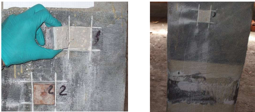
Figura 1.3 - Esempio di prove di Pull Off su un applicazione di CFRP
