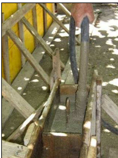
3) Sistema di costipamento Vibratura
