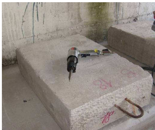
Scalpellatore con utensile a punta conica installato.
