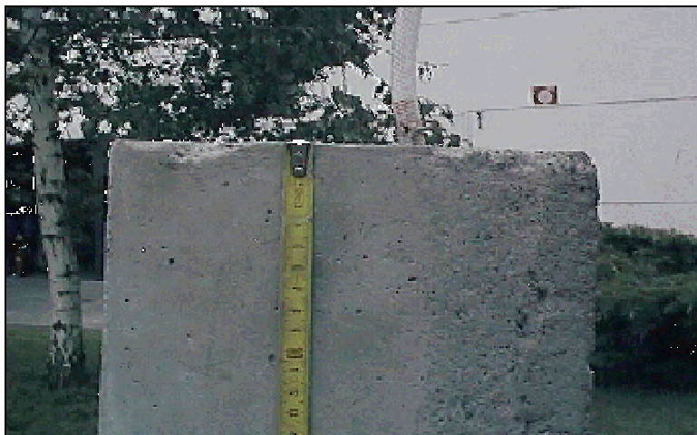
Figura 2.1 : La presenza del lattime di cemento rende questo sottofondo non idoneo all'applicazione di rinforzi esterni
