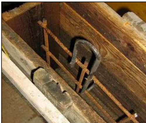
1) Posizionamento rete metallica
