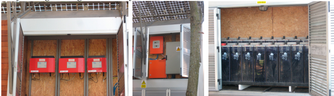
Locale tecnico (batterie collegate ai pannelli fotovoltaici)
