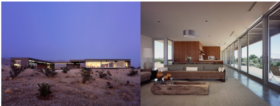
Figura 26. Hidden Valley Home , immagine del prospetto principale e degli interni
