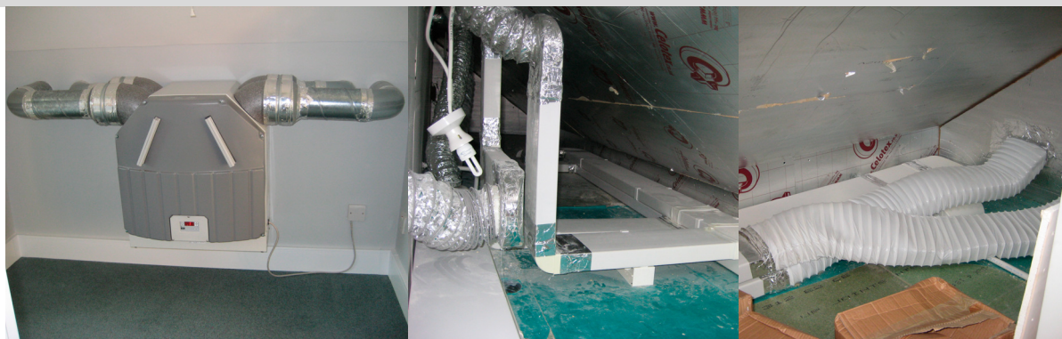
impianto di ventilazione meccanica con il recupero del calore MVHR (Mechanical Ventilation with Heat Recovery) e locale tecnico
