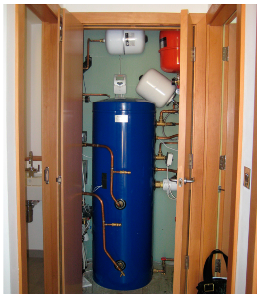
Sistemi solari termici: serbatoio di accumulo per l'acqua calda
