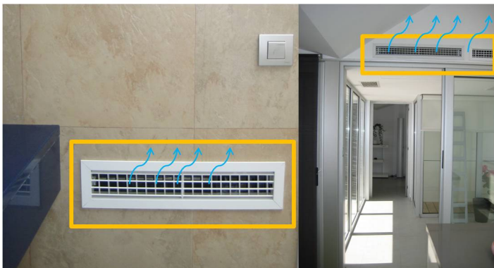
Per la climatizzazione estiva è utilizzata la Tecnologia Solar Cooling che permette di trasformare l'energia termica prodotta dal sistema solare in "aria fredda".
