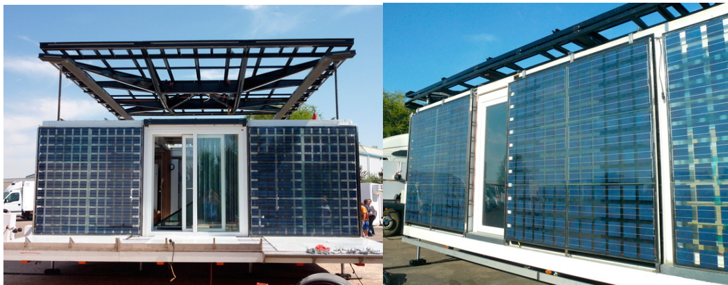
Figura 69. "B&W House": facciata fotovoltaica
