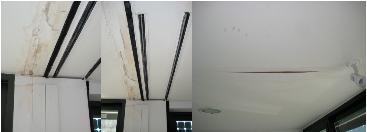
Problemi di umidità intorno alla parete mobile
