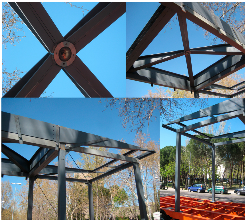
Figura 43. Struttura in acciaio della copertura rotante
