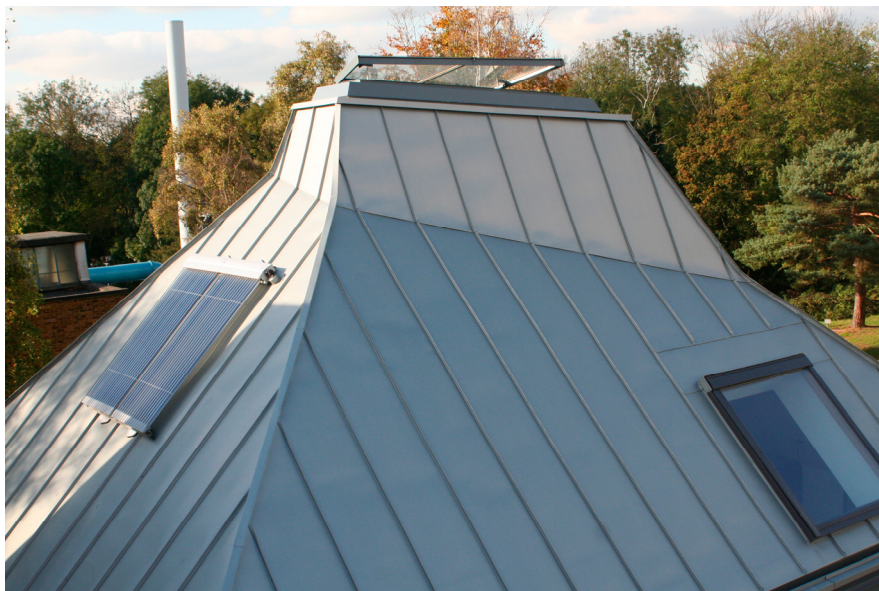
Dall'immagine si evince la particolare conformazione del “tetto lanterna”, il lucernario, i pannelli solari
