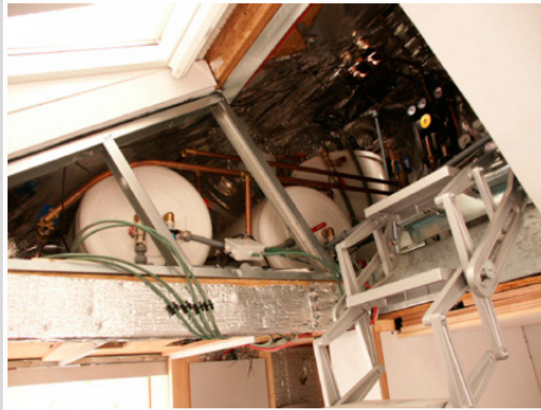
Locale tecnico (serbatoi per l'acqua calda)
