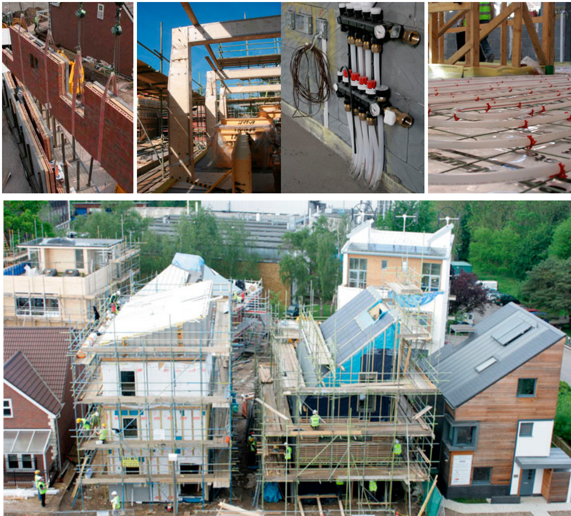
Figura 32. Immagini della costruzione dei 7 prototipi prefab presso l'Innovation Park
