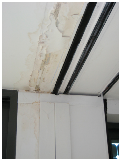
Figura 63. Problemi di umidità sulla parete mobile del prototipo “ Magic Box ”
