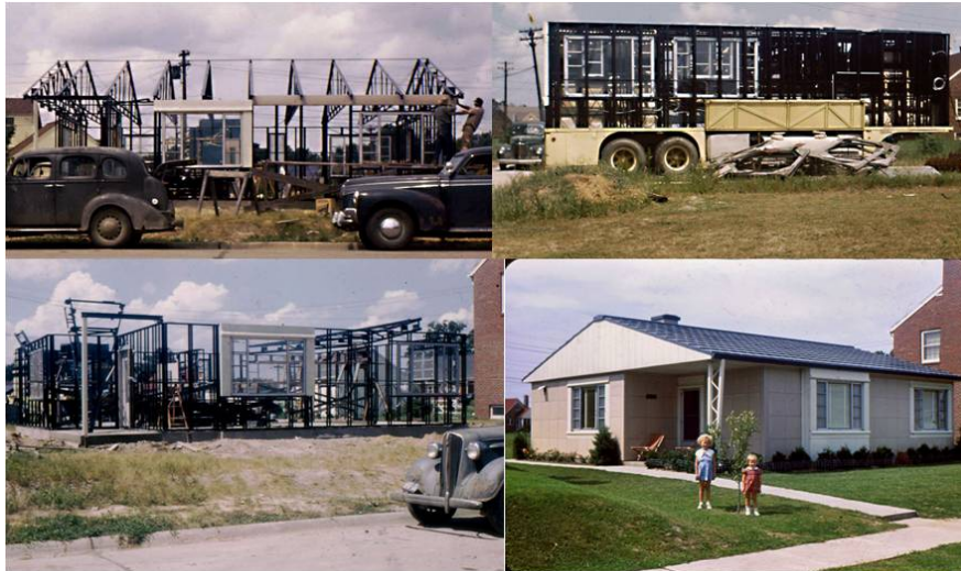
Figura 6. Agosto 1949/Inverno 1950, Lustron Home Installation, Davenport, IA
