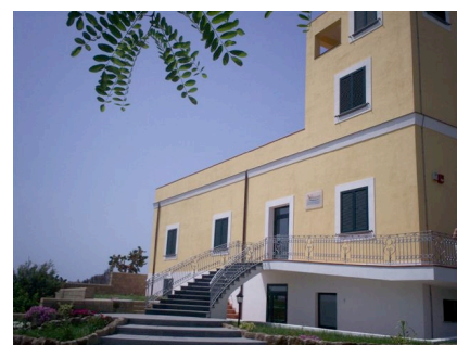
Figura 58 - Il Museo della Migrazione su cui è stata condotta la sperimentazione e su cui verranno installati i pannelli fotovoltaici organici
