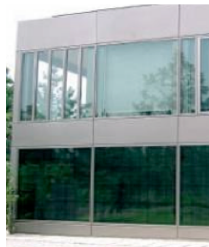
Figura 47 - La facciata della Toyota Dream House
