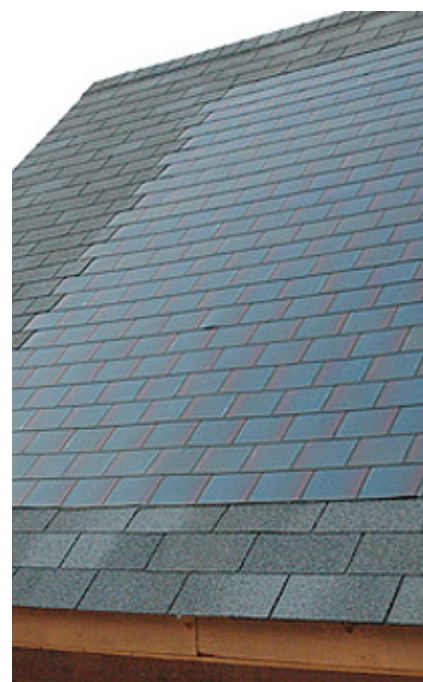
Figura 30 - L'integrazione delle tegole fotovoltaiche nella Dow Power House
