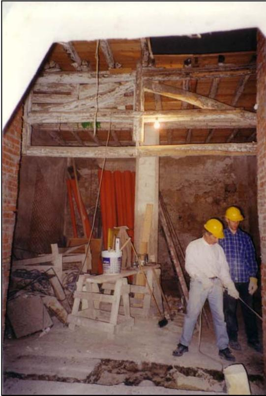
7.2. - Fig.34: Immagine di cantiere - Si noti il solaio originario prima della demolizione
