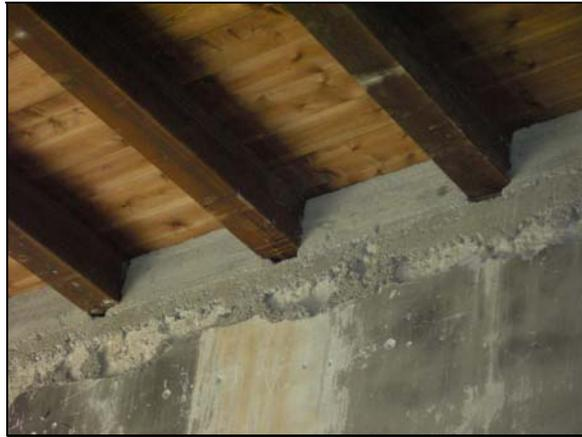
7.1. - Fig. 8: Particolare di un solaio ligneo ricostruito insieme al cordolo antisismico in calcestruzzo armato
