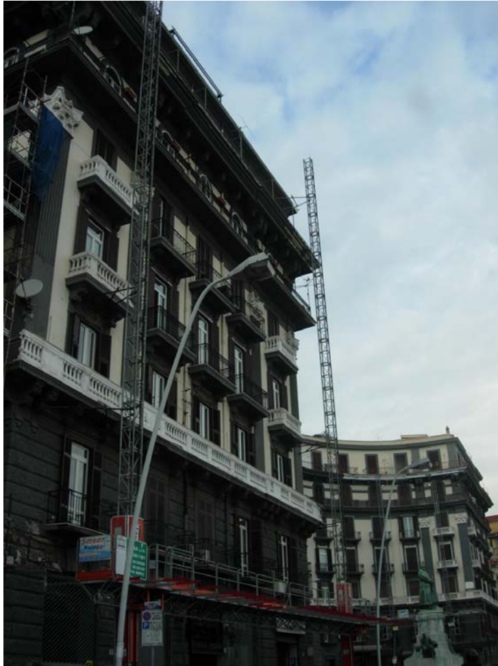
Ponteggio motorizzato in Via Partenope, Napoli, ottobre 2005
