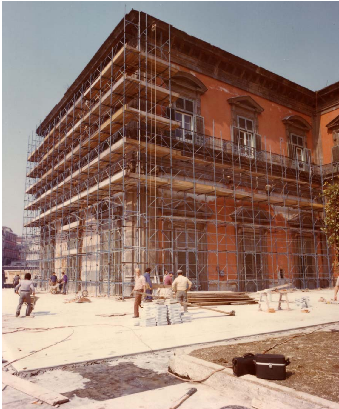
ponteggi ed allestimento cantiere Palazzo Reale, Napoli, 1970
