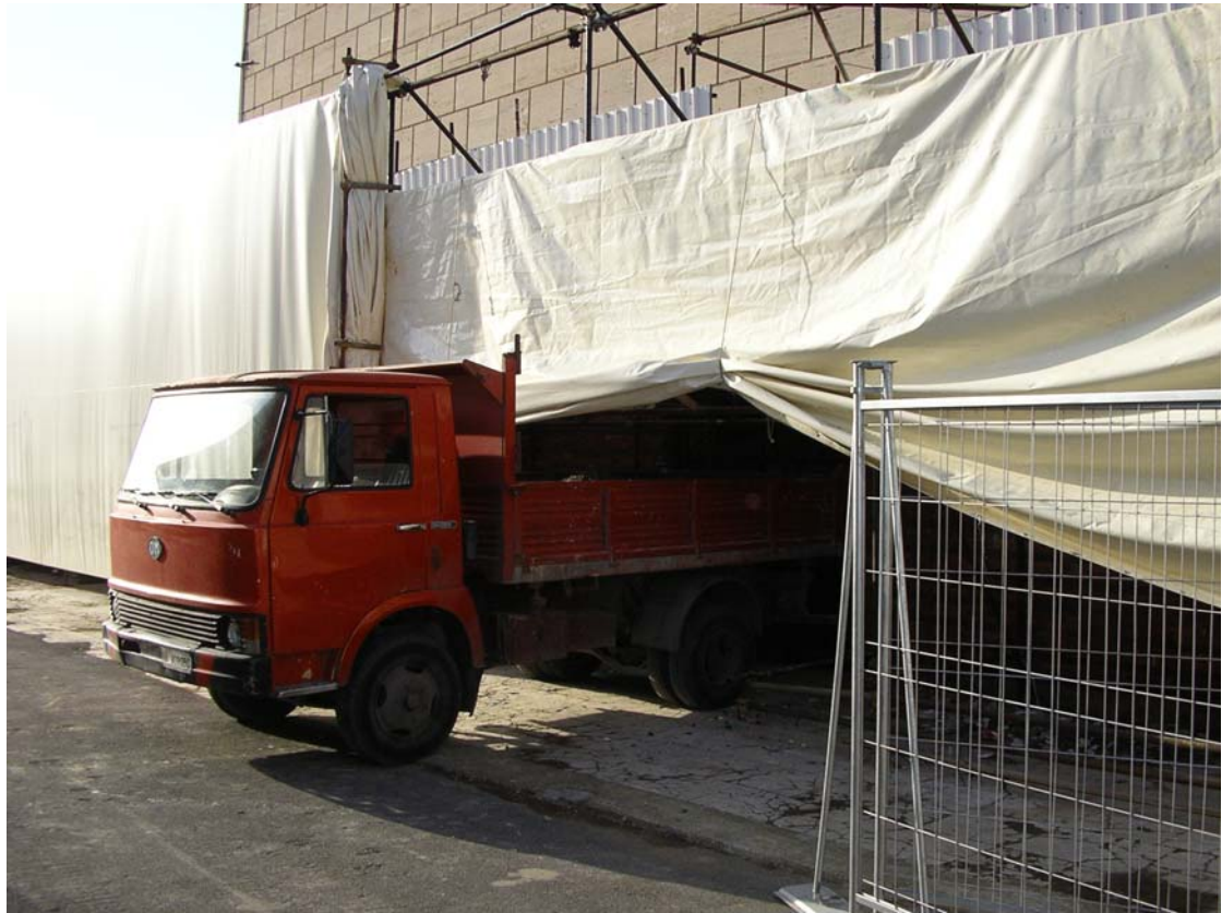
momenti di carico materiale di risulta
