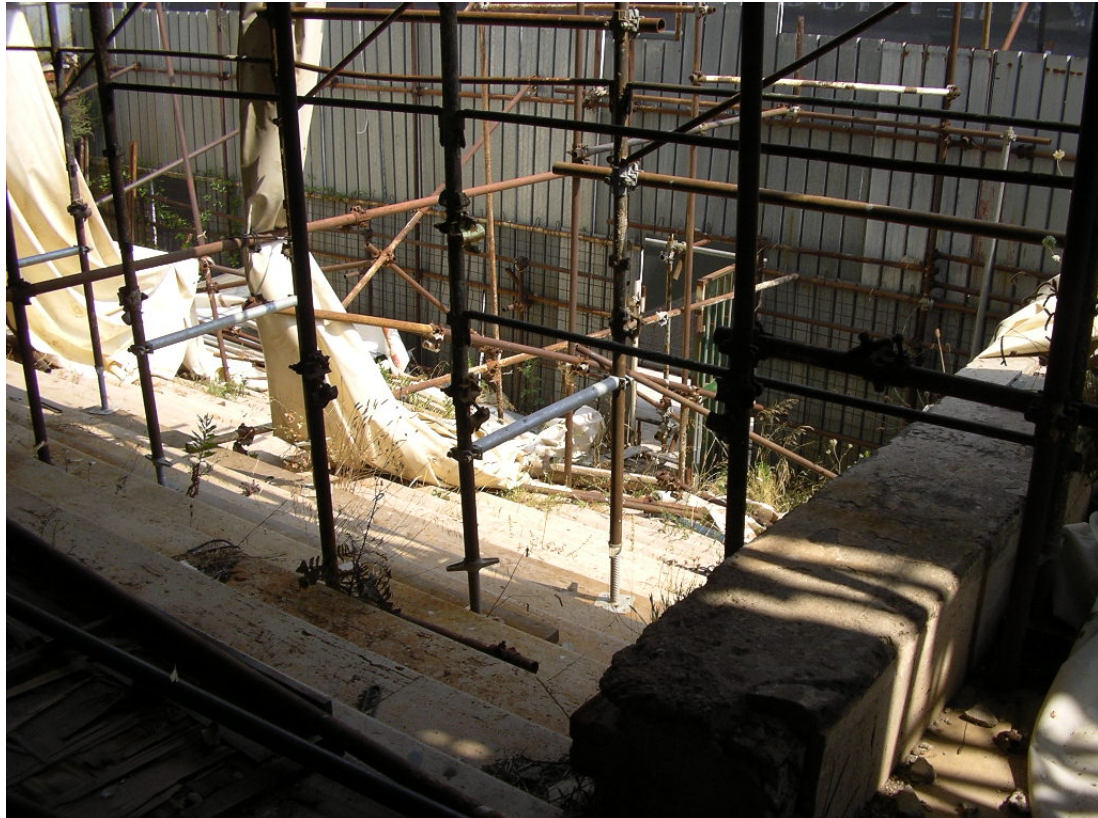
piano terra con ponteggi del 1997
