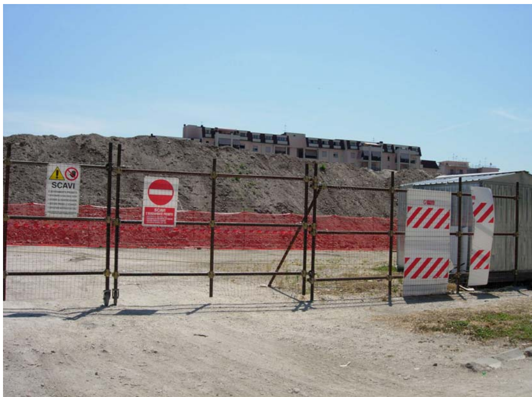
l'ingresso carrabile al cantiere
