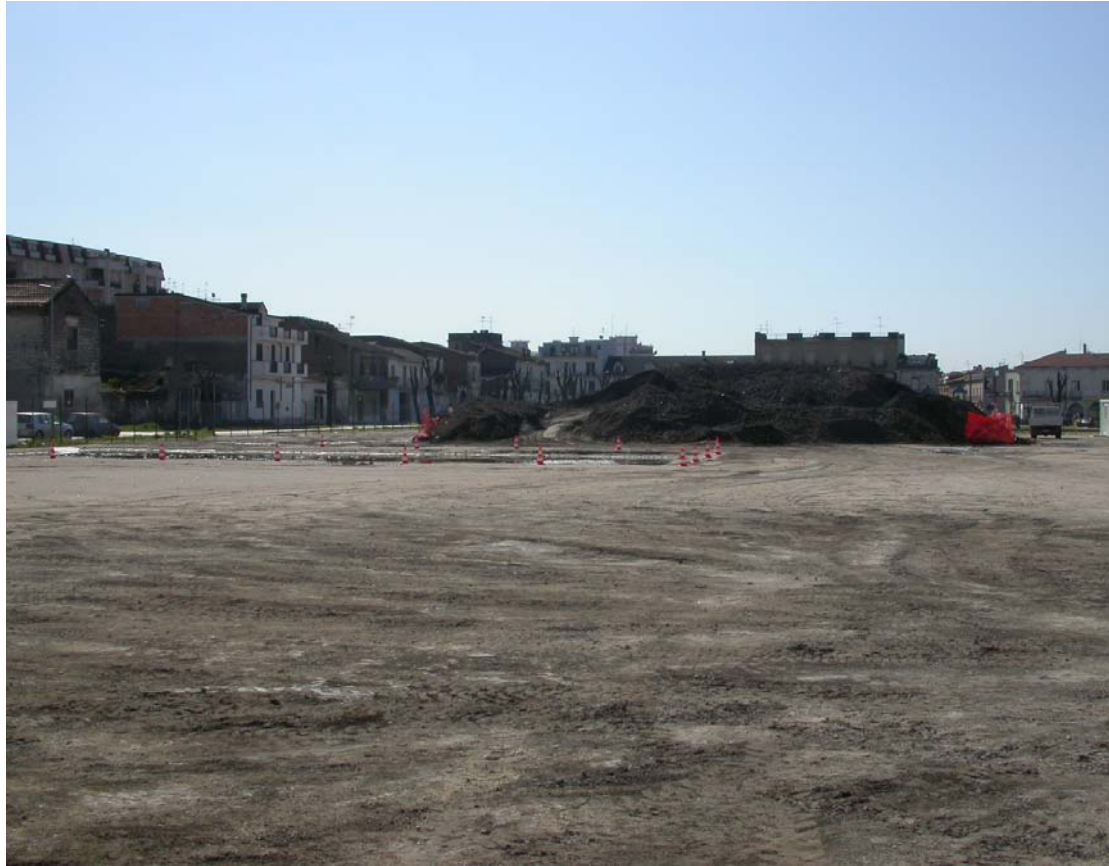
luogo di manovra e in fondo stoccaggio materiale
