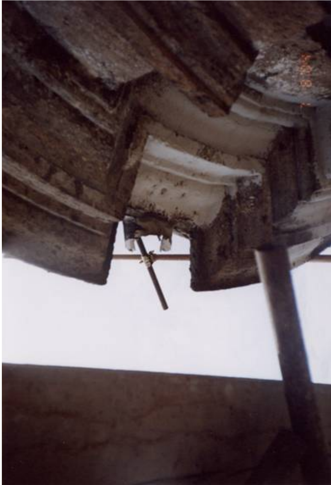
dettaglio delle parti mancanti
