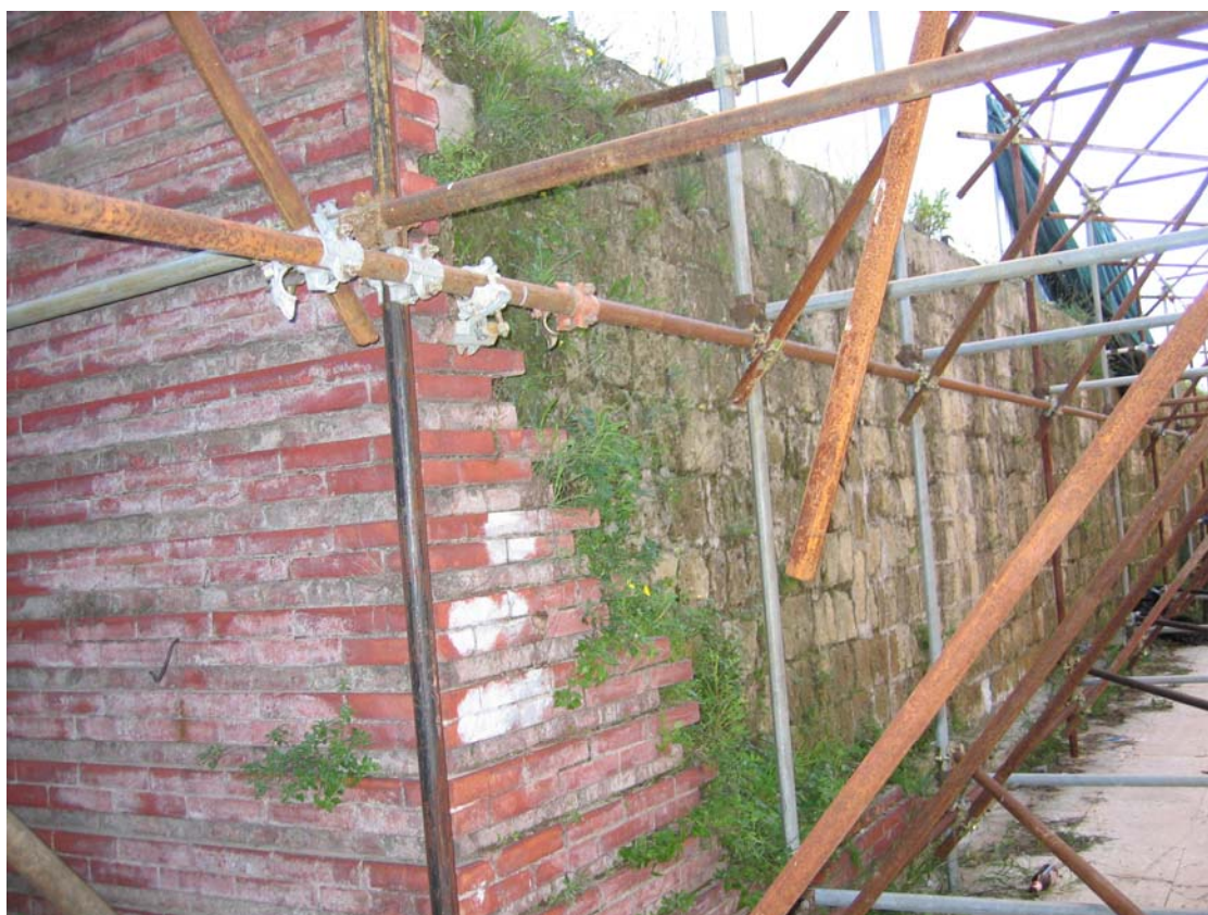
esterno struttura piano terra della Torre
