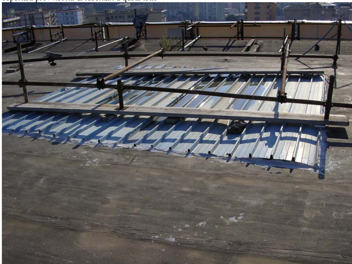
copertura provvisoria di lucernari a quota tetto
