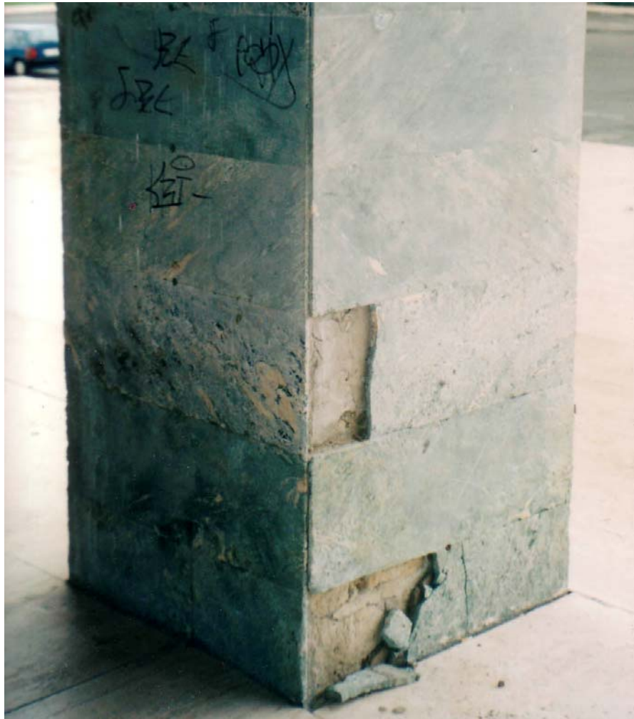
distacchi parziali delle lastre di marmo
