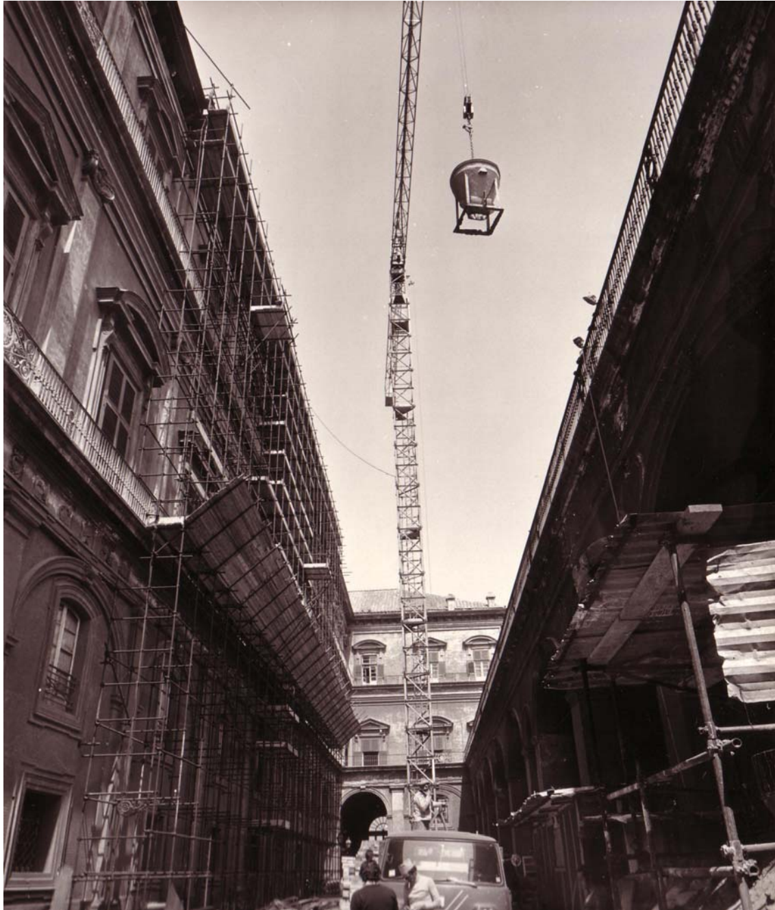
Palazzo Reale in Napoli, cantiere di restauro delle facciate, fine 1970
