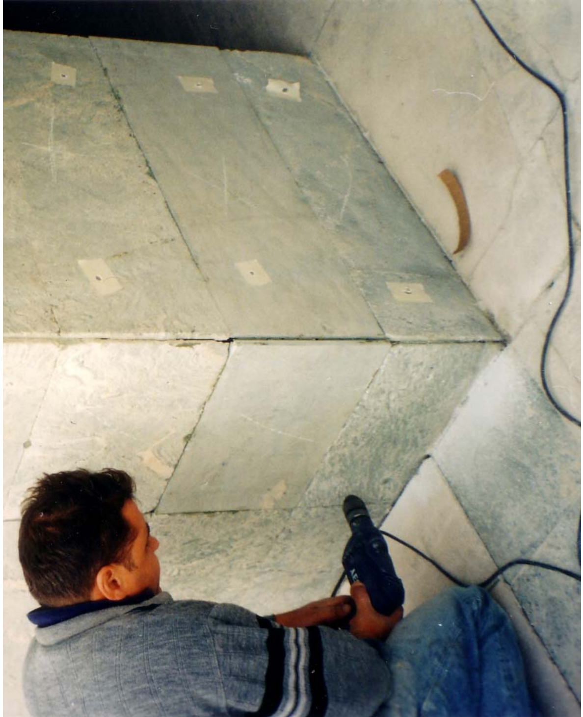
esecuzione dei fori
