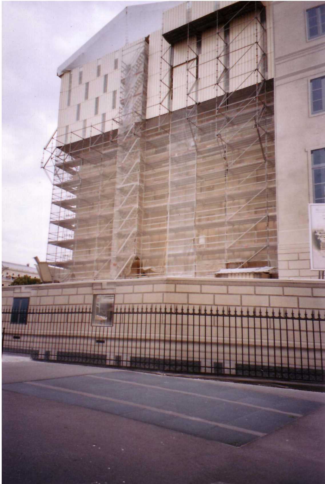
ponteggio ed allestimento cantiere Palazzo di Giustizia, Parigi, 2003
