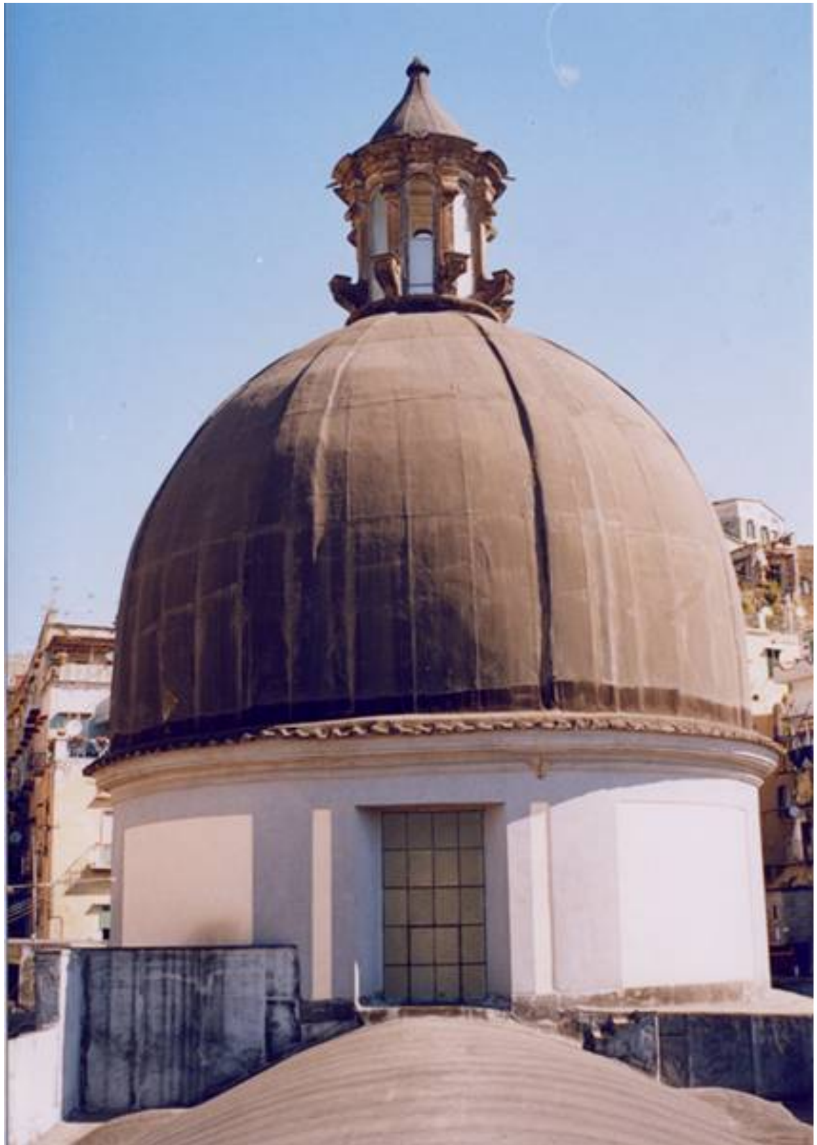
La cupola vista dall'esterno prima dell'intervento, novembre 2003
