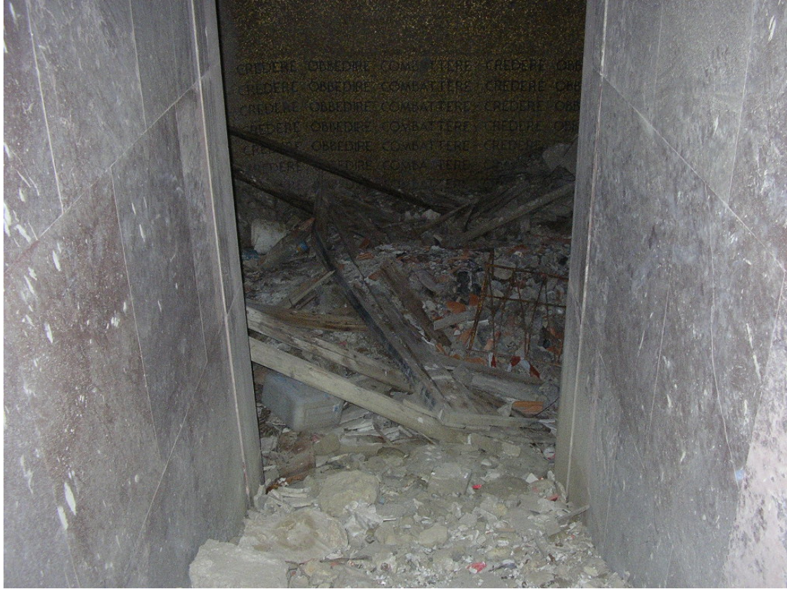
scala inaccessibile verso la saletta dorica durante il sopralluogo
