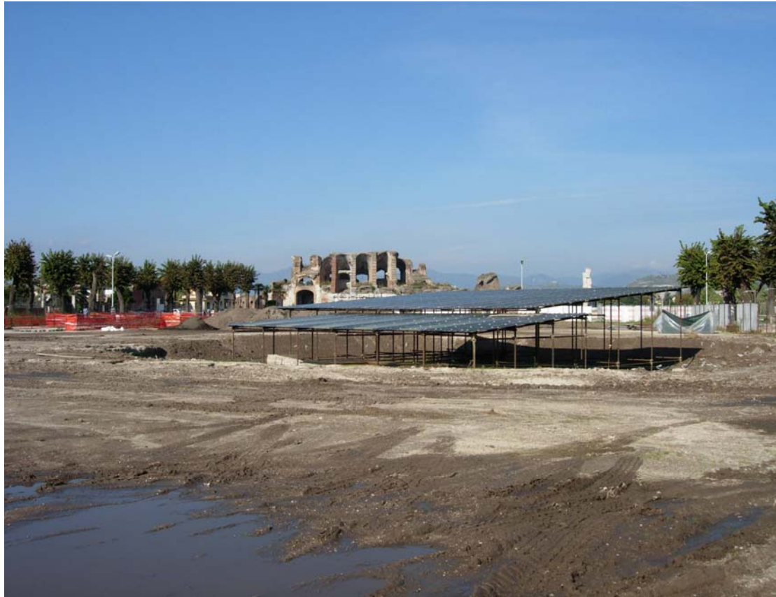
Immagine degli scavi della 3 a area a copertura terminata
