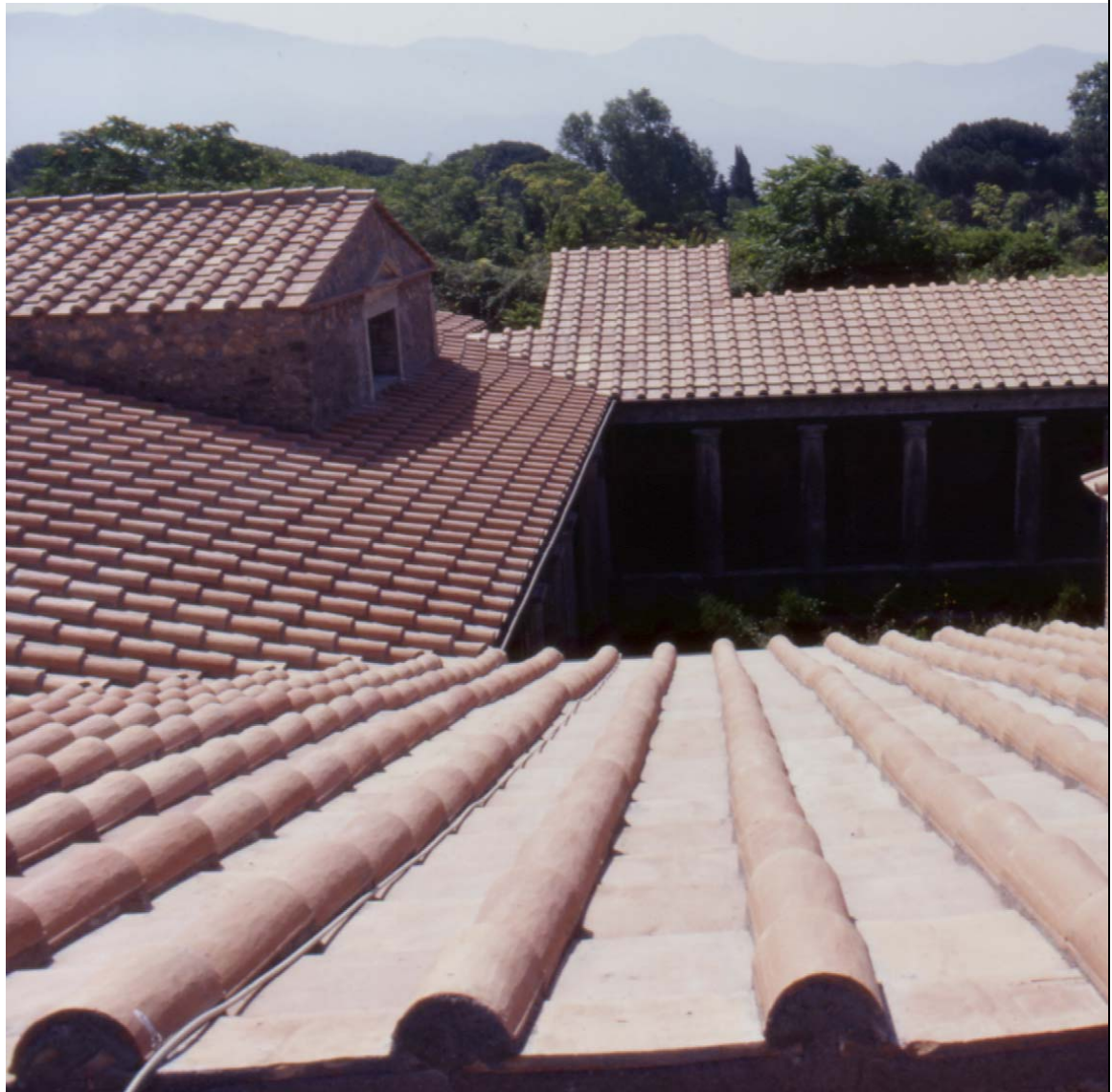
foto ad intervento effettuato sulle coperture
