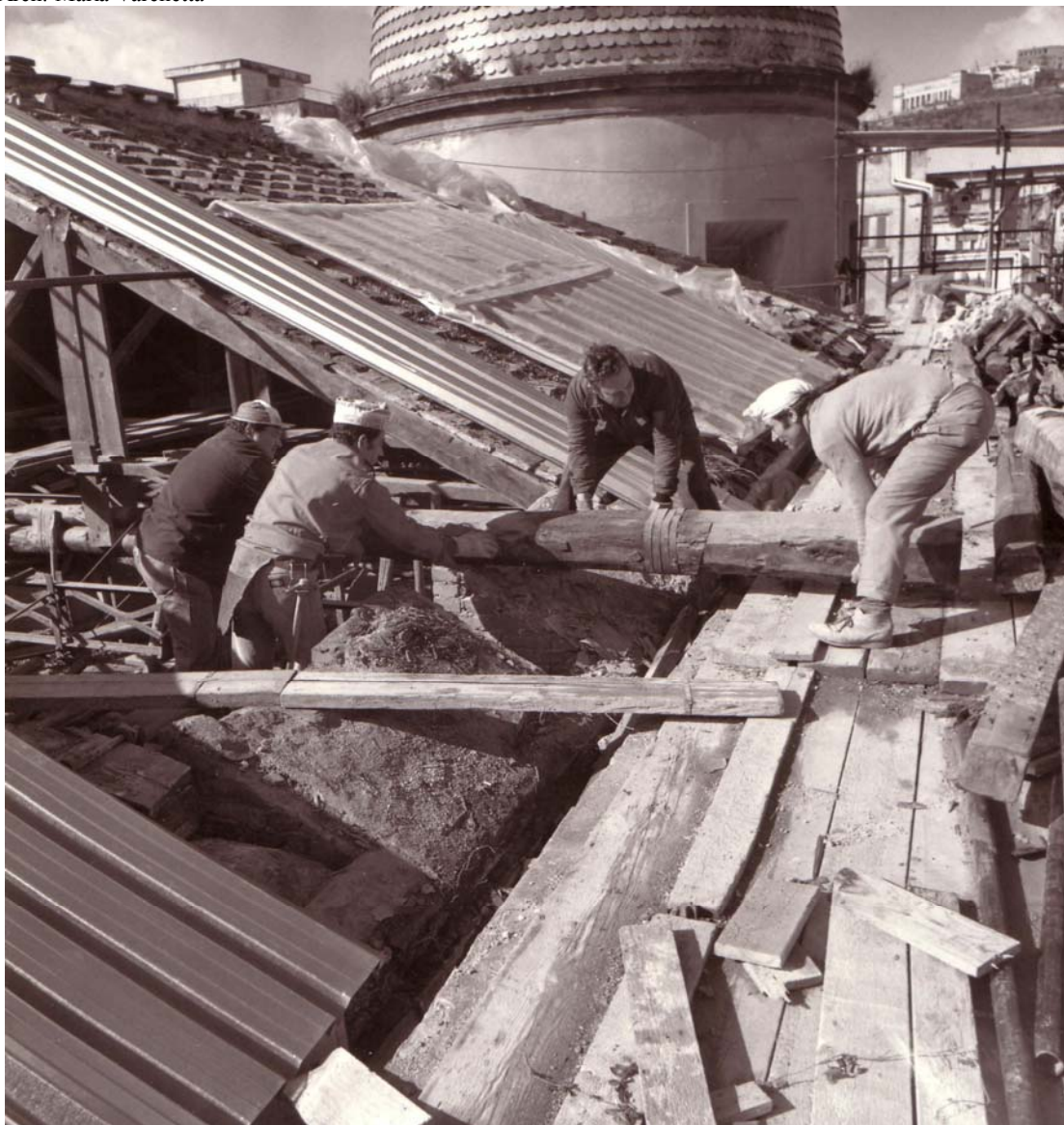
cantiere di restauro nel 1970, copertura tetto della chiesa di Santa Maria Donnaromita in Napoli
