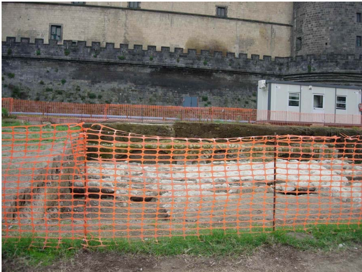
particolare degli scavi di restauro archeologico, piazza Municipio, Napoli, ottobre 2005
