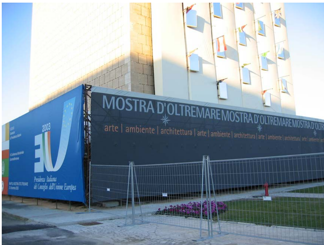
dicembre 2003, esterno della Torre con ponteggio e schermatura con teli a tutta altezza
