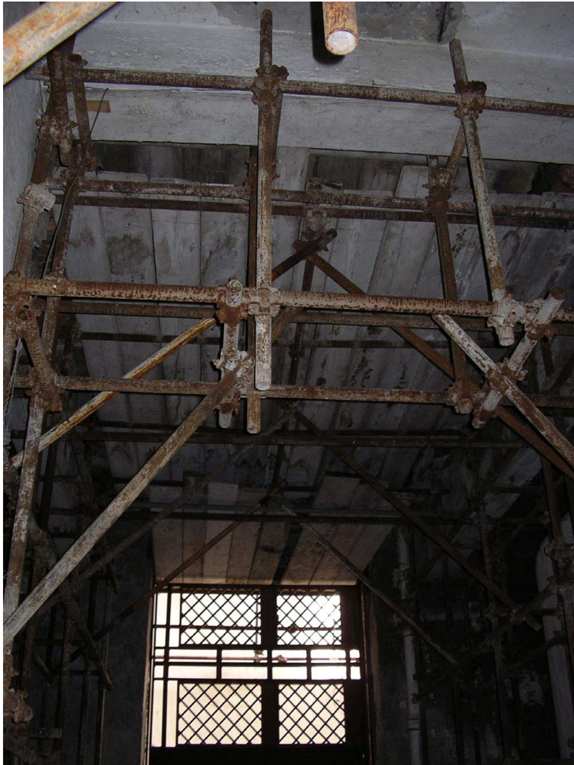
sopralluogo 2004, ingresso laterale per scendere al piano fondazioni.
