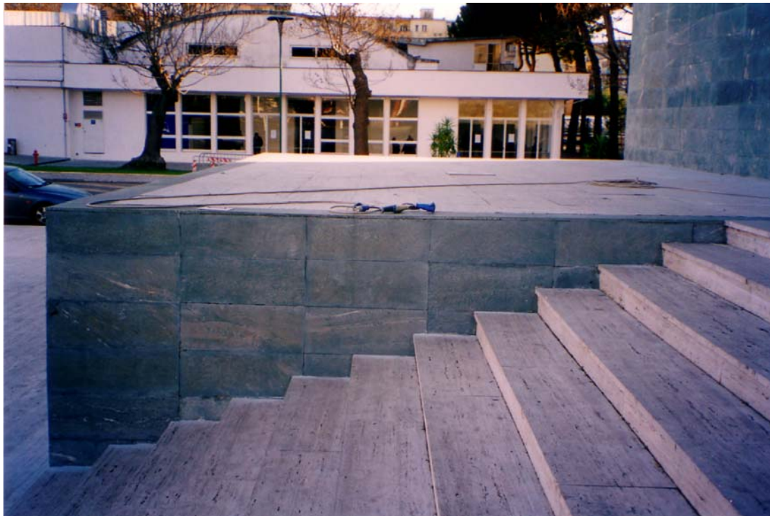
particolari dello scalone principale
