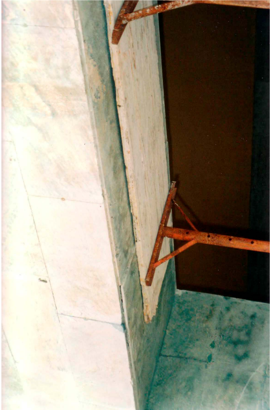
prime opere provvisionali in alcune zone considerate a rischio caduta
