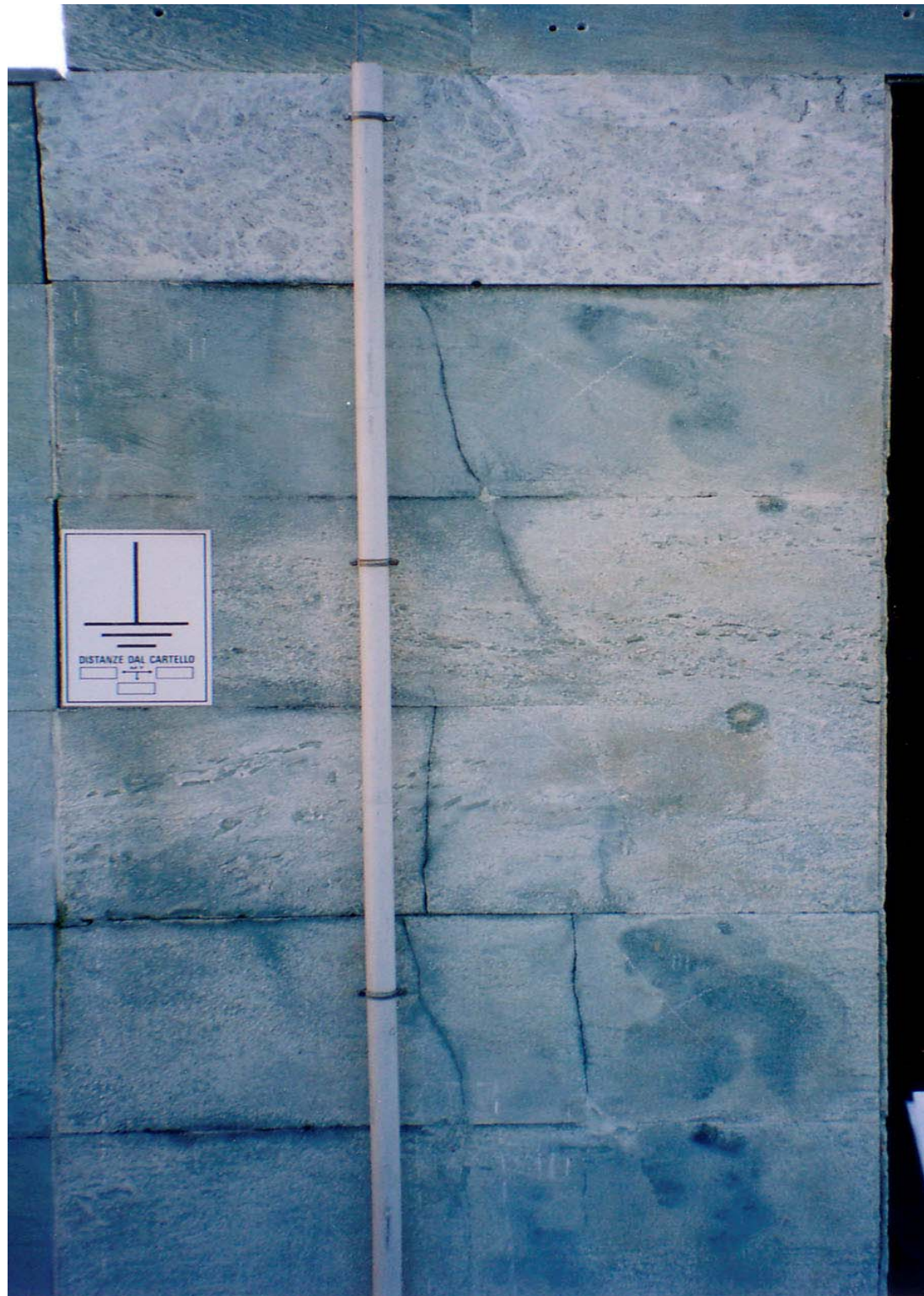
evidenti fessurazioni del marmo
