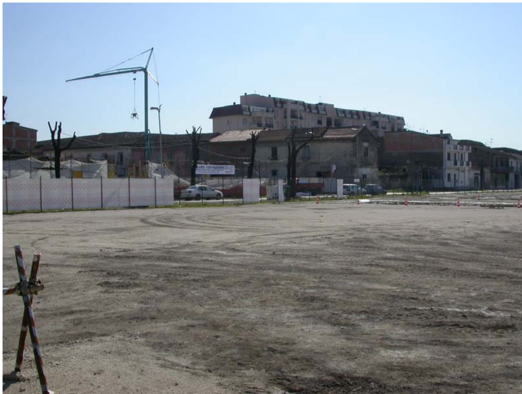
3 a area di scavo prospiciente le abitazioni
