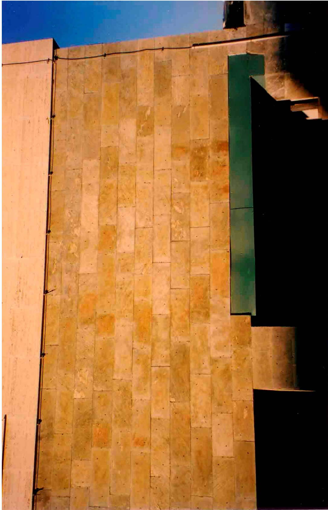
dettaglio facciata laterale subito dopo l'intervento sia sull'architrave, sia sulle lastre di marmo
