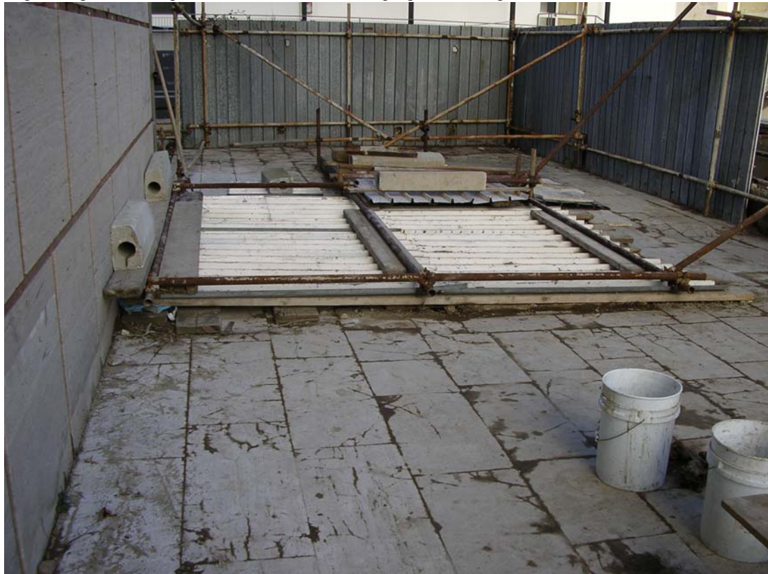
Coperture provvisorie per evitare infiltrazioni di acqua piovana nel piano fondazioni
