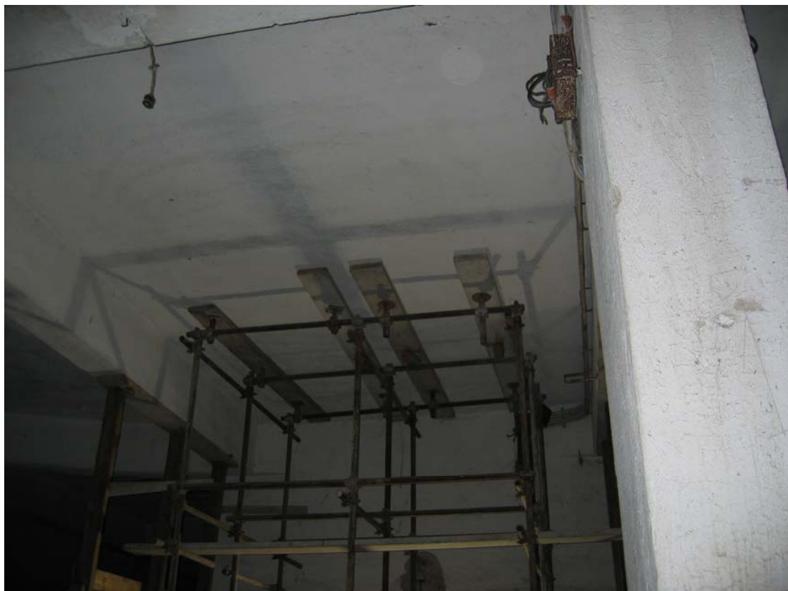
messa in sicurezza per le indagini strutturali pre-progetto. Dicembre 2004
