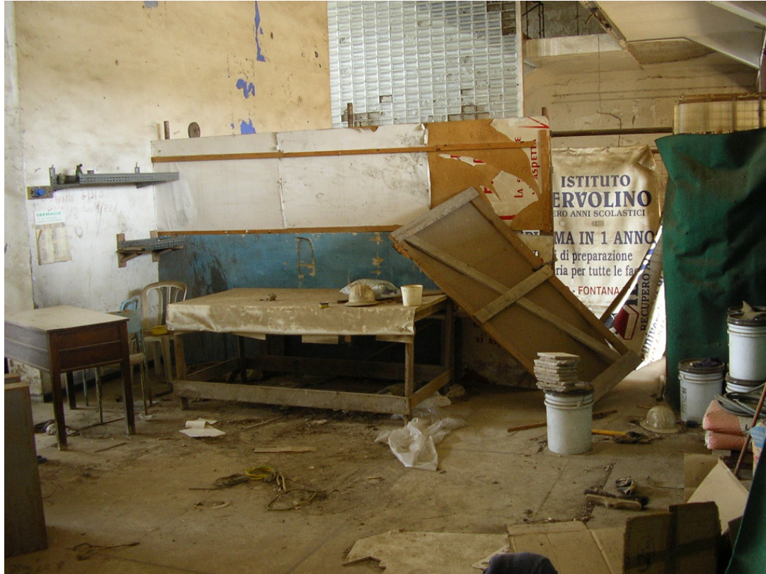
Immagini prima dell'organizzazione del cantiere durante il sopralluogo nel luglio 2004
