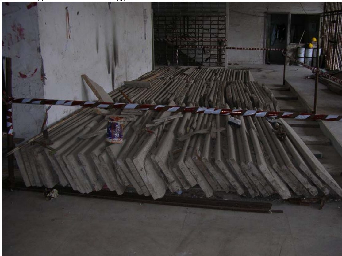
piano terra, deposito materiale per ponteggi interni e spogliatoio per operai
