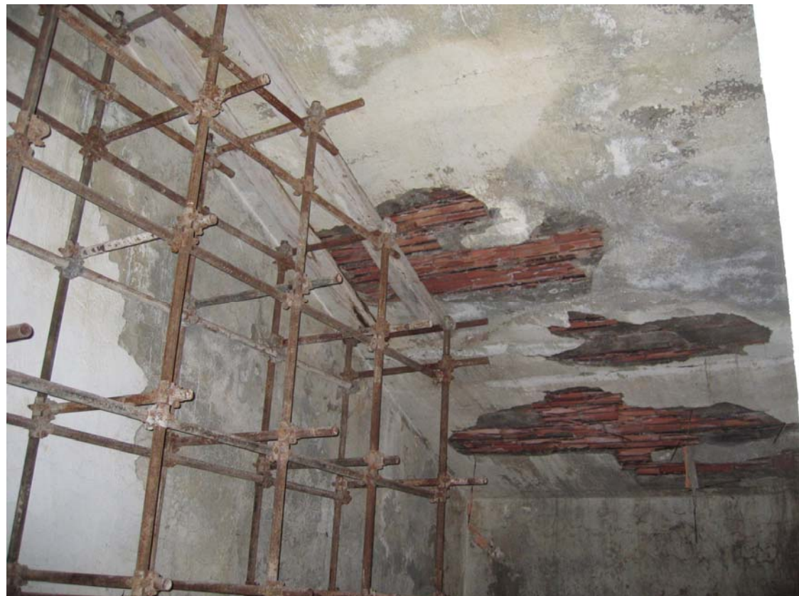
opere provvisionali per i sondaggi fatti in fondazione
