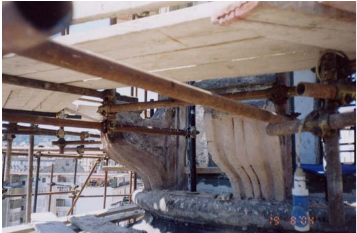
opera finita grazie alla capillare ricostruzione in cantiere
