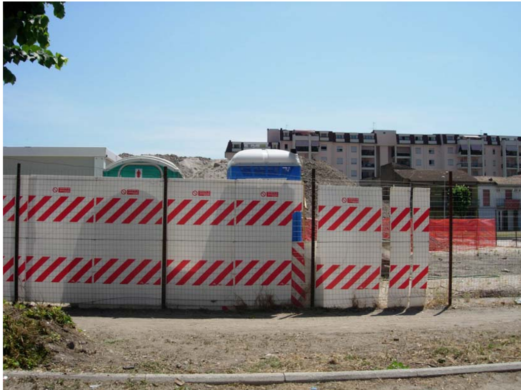
allestimento del cantiere e dei suoi servizi
