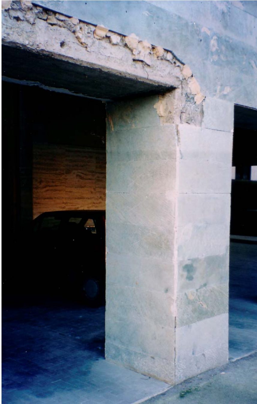
sopralluogo del 2003: foto che testimonia il distacco delle lastre degli arcitravi che ha reso urgente l'intervento
