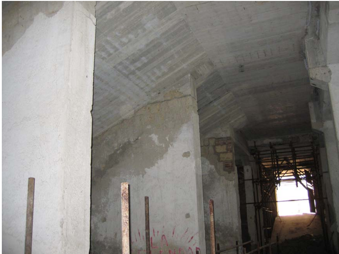
rampa di accesso al cantiere del piano di fondazione
