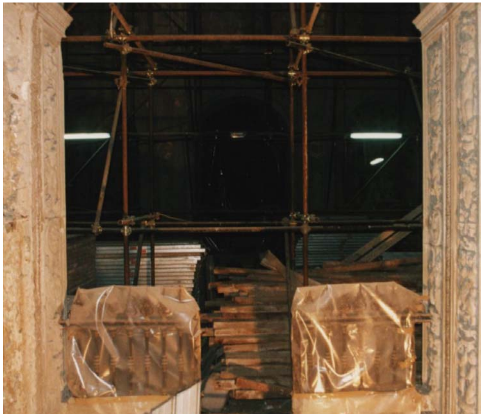
ponteggio in acciaio all'interno della chiesa di Santa Maria delle Grazie a Caponapoli, Napoli, 2000
