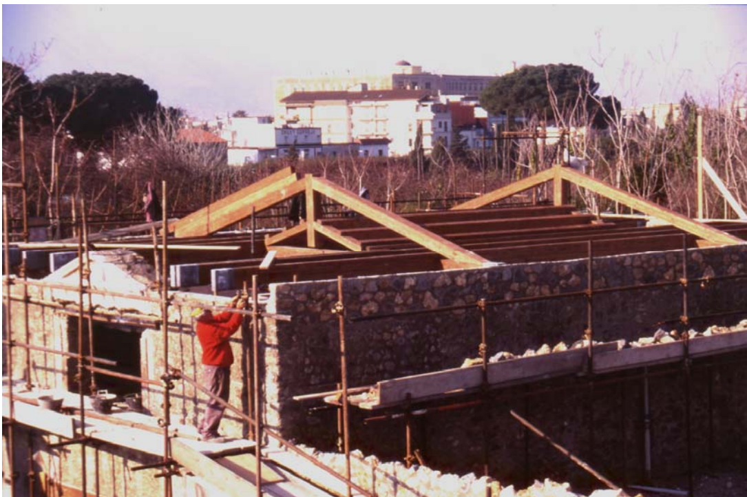
cantiere di restauro delle coperture nell' intervento del 1989
