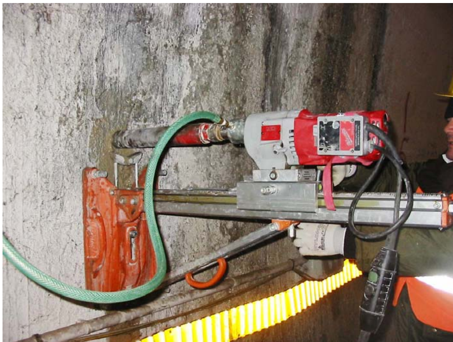
Prelievo campione (per successiva prova in laboratorio) dal rivestimento in calcestruzzo.
