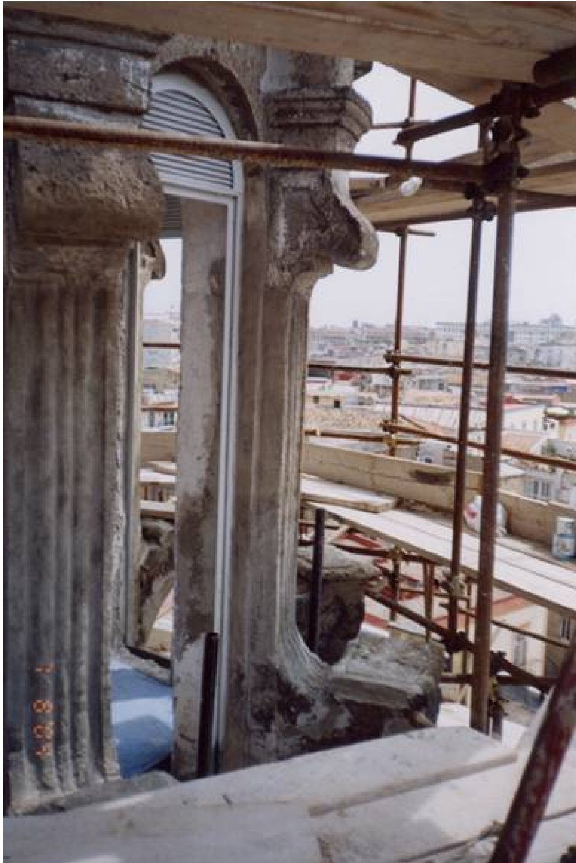
Ricostruzione delle parti mancanti delle lesene con malta tipo calce rasoprietra tirate con sagome di legno
