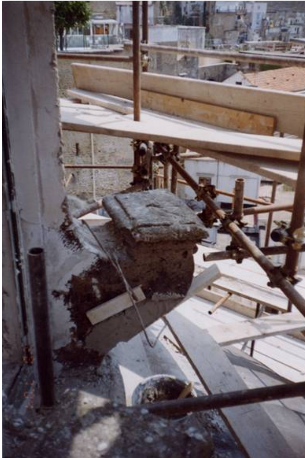
Il ripristino delle cornici è stato realizzato con apposite sagome di legno preventivamente riprese con calchi di gesso e catalogate.
