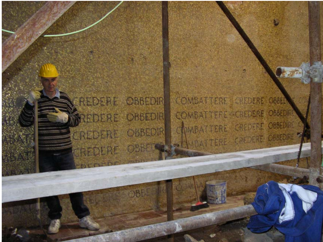
lavori nella saletta dorica effettuati con l'installo di un impianto temporaneo di illuminazione del tipo da cantiere, potenziato sulle zone oggetto di studio con esclusione all'allacciamento alla rete esterna
