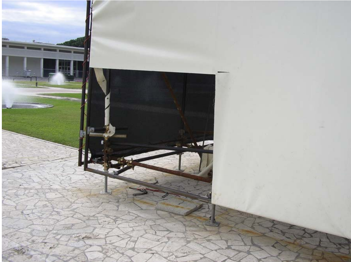
allestimento ponteggio esterno per recinzione cantiere Torre delle Nazioni
