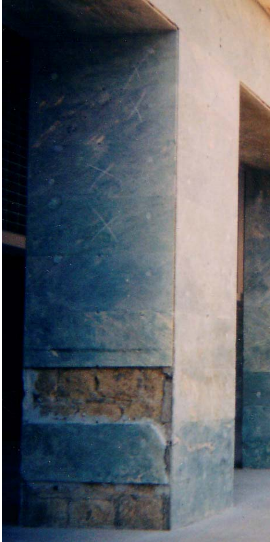
dettaglio sulle colonne
