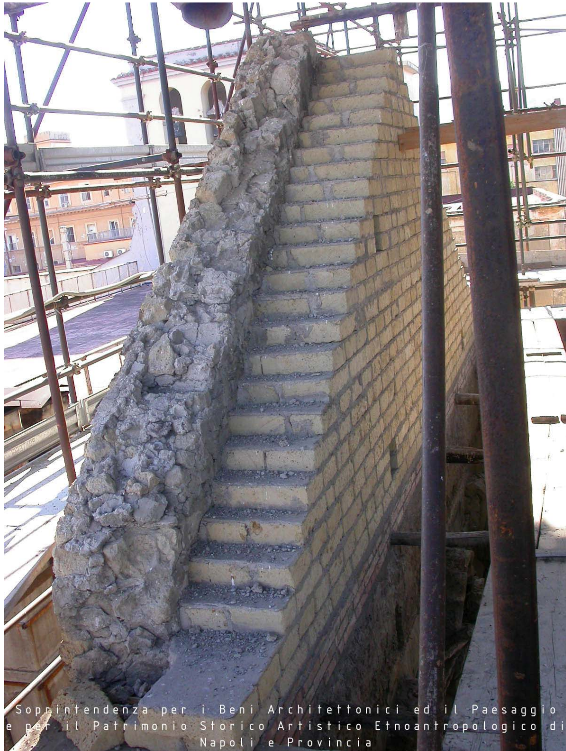
intervento strutturale in facciata, Chiesa s. Maria delle Grazie
