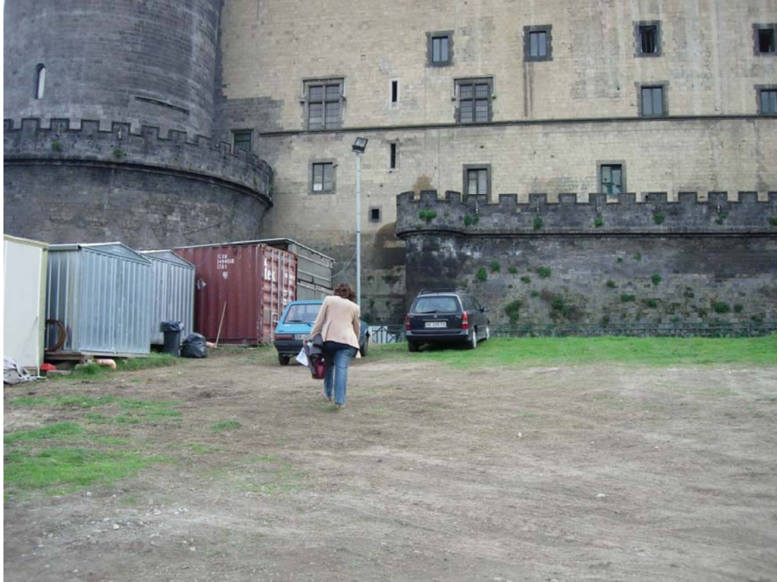
particolari dei servizi annessi all'allestimento del cantiere in piazza Municipio
