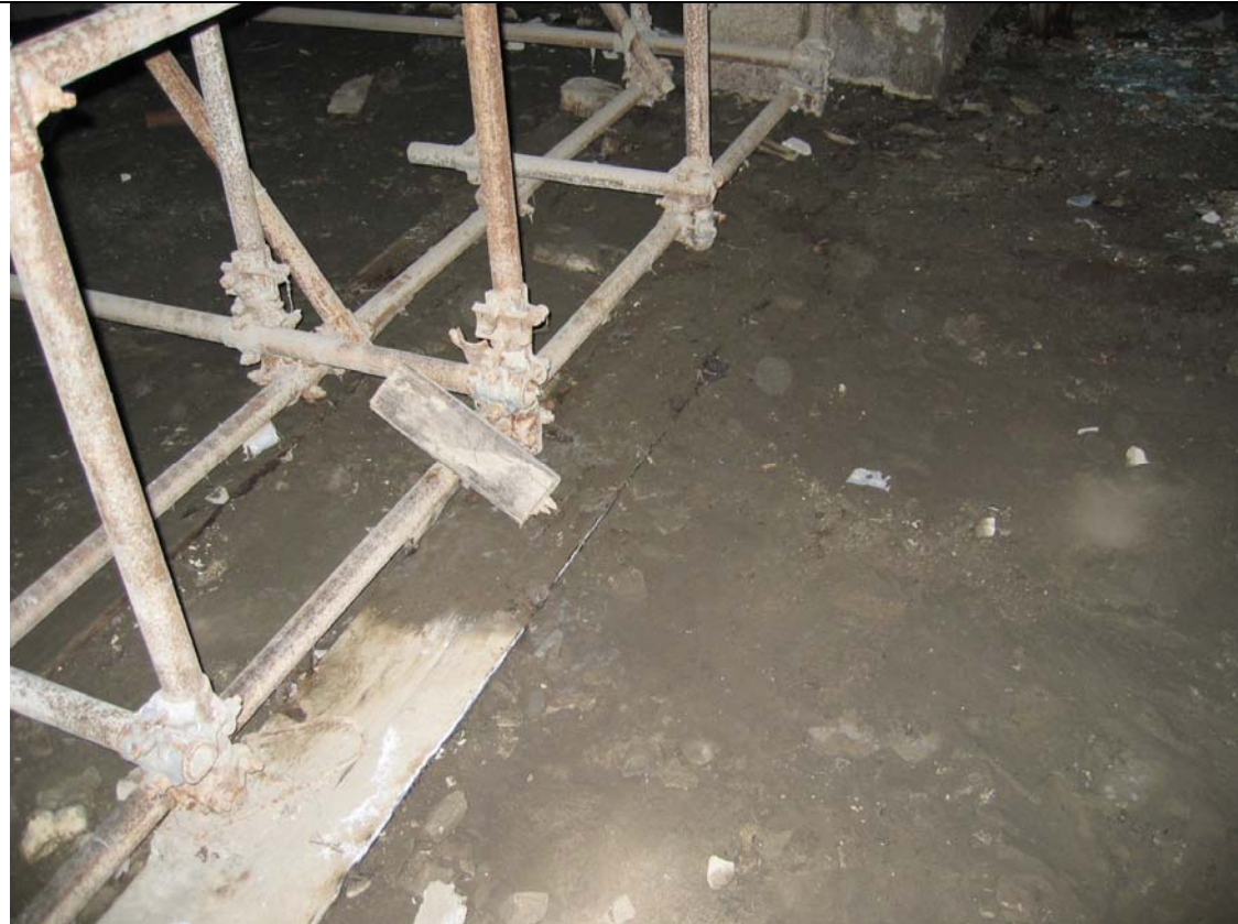
piano di fondazione con nuove opere provvisionali
