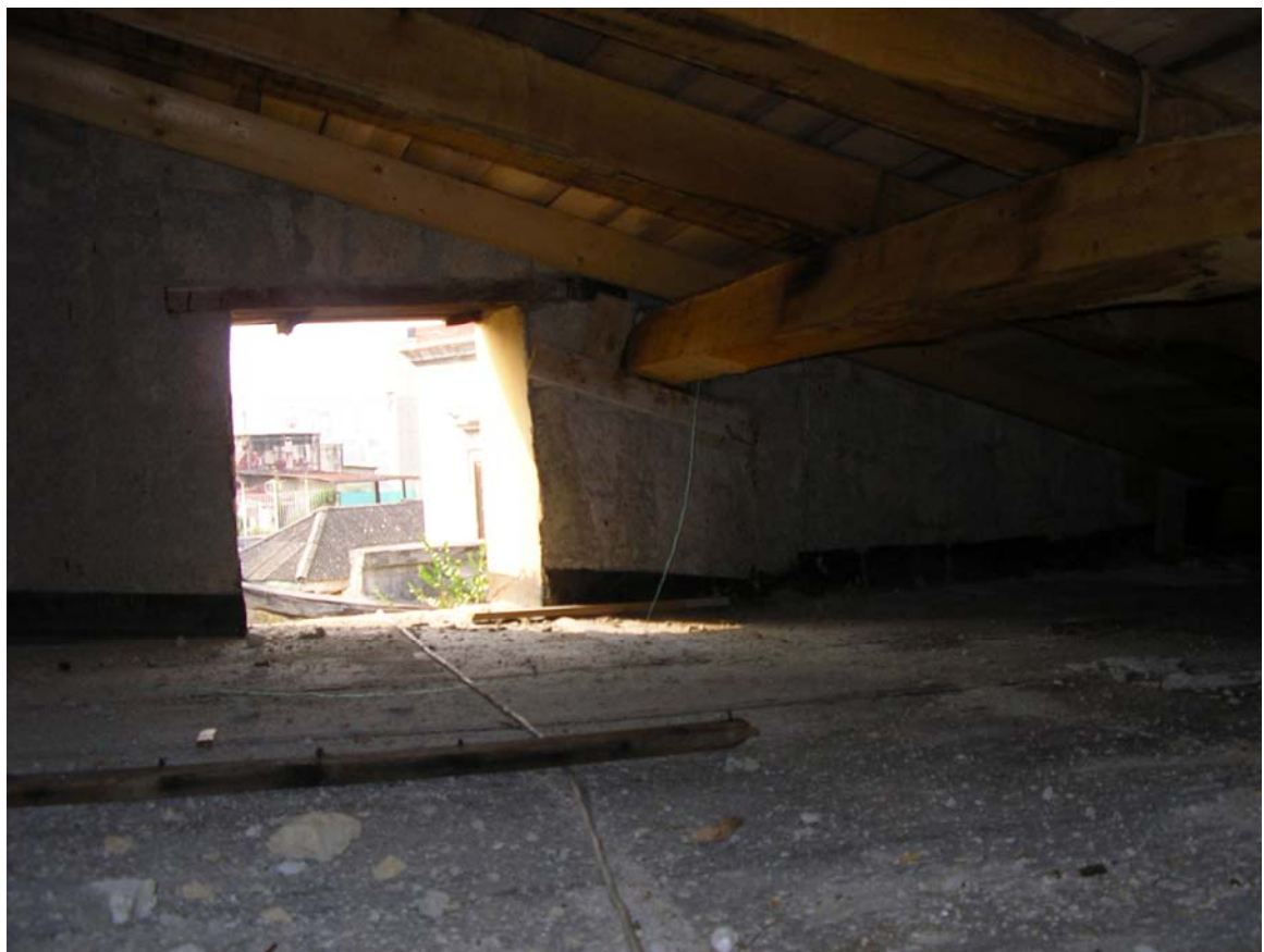
foto sottotetto a lavoro terminato
