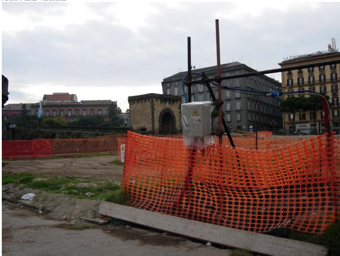
impianto elettrico a servizio del cantiere archeologico, Napoli, ottobre 2005
