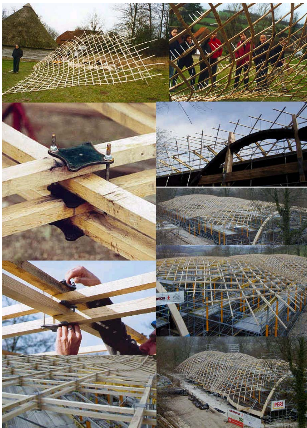
Fig. 13: Edward Cullinan, Downland Gridshell per il Weald & Downland Open Air. Fasi di montaggio della struttura, dalla sperimentazione di un prototipo di piccole dimensioni, alla copertura dei laboratori.
