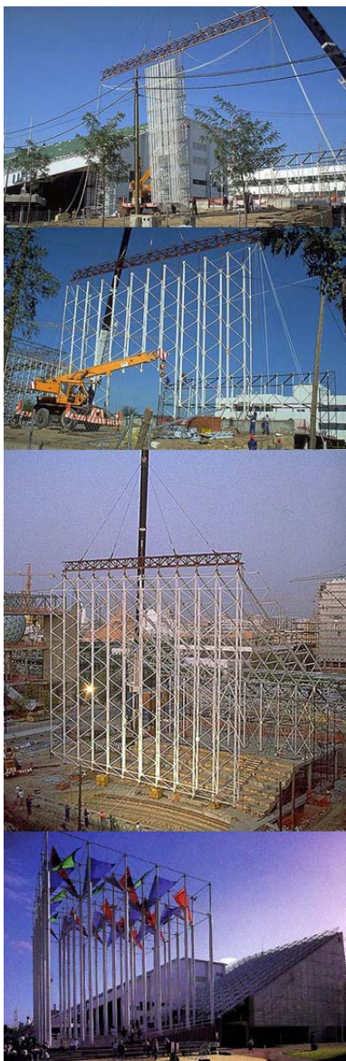
Fig. 17: Padiglione del Venezuela all'Expo di Siviglia del 1992. Architetti: Grupo Estran. Nelle immagini le fasi di montaggio che si sono protratte per un giorno appena.
