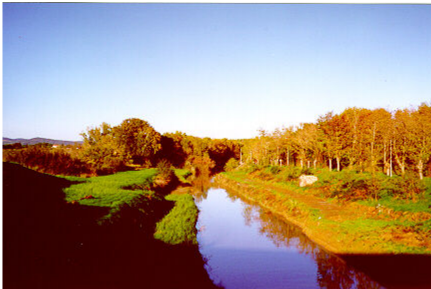
Figura 2.4 – Diversivo in destra al fiume Ombrone
