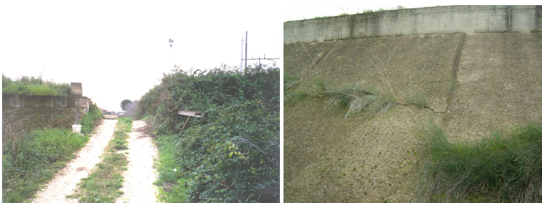
Figura 3.24 – Dissesti negli argini del fiume Volturno
