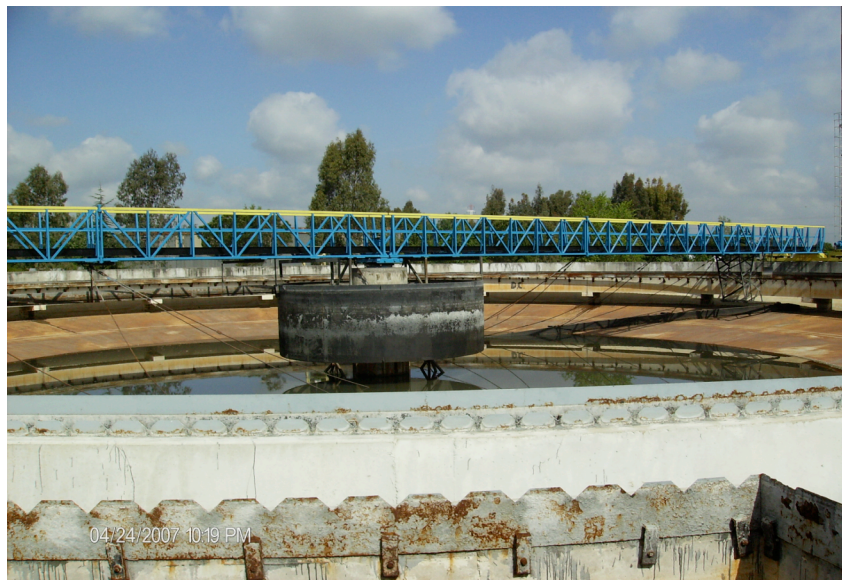
Foto 3.1 - Vasca di sedimentazione primaria vuota, per manutenzione
