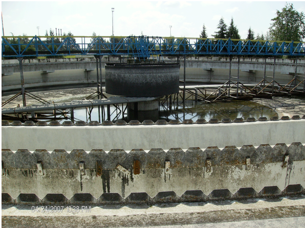
Foto 4.2 - Vasca di sedimentazione secondaria vuota, per manutenzione
