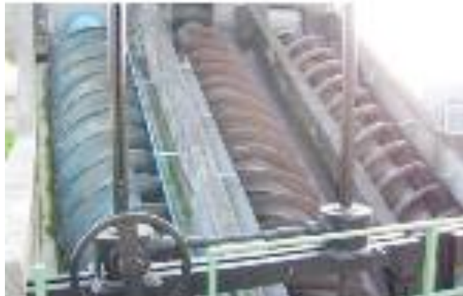
Foto 1 - Stazione di sollevamento a coclee
