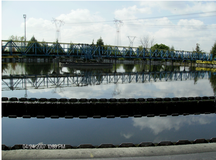
Foto 3.2 - Vasca di sedimentazione primaria in attività
