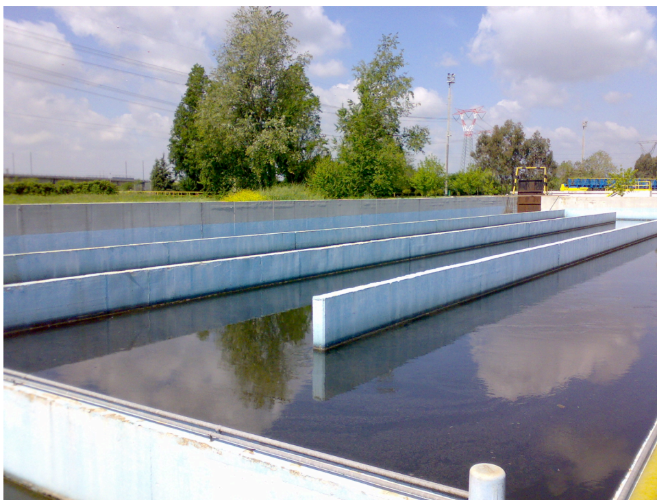
Foto 5.1 - Serpentine della vasca di disinfezione
