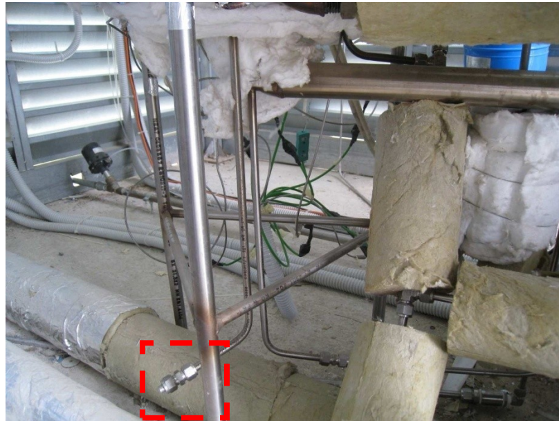
Figura 18 - Condotto in ingresso al sistema bruciatore-reformer
