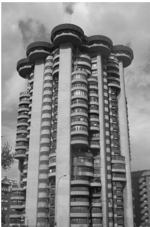
Saenz de Oiza, Edificio Torres Blancas, Madrid, 1967.
