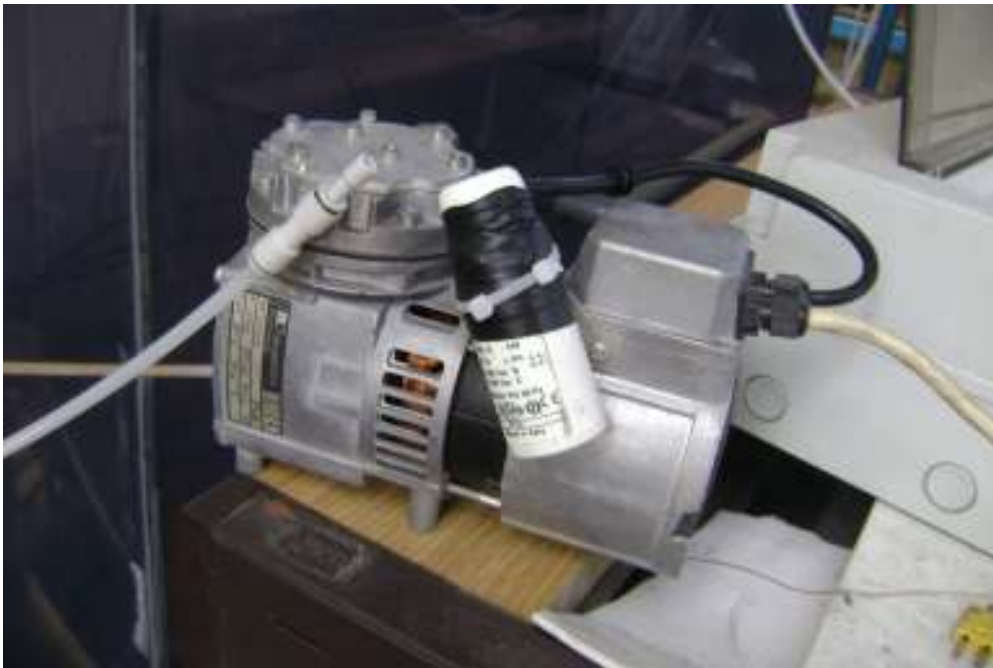
Fig.3.27. Pompa di prelievo dei gas post-scrubbing
