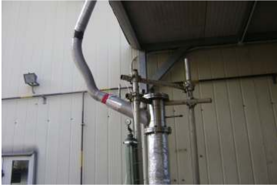
Fig.3.16. Scarico dei gas ed immissione dell'acqua
