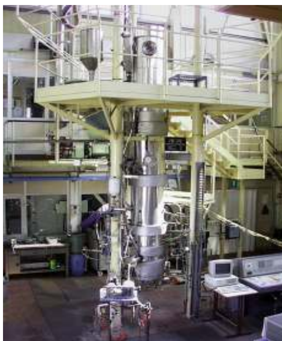
Fig.3.4. Impianto pilota di combustione a letto fluidizzato da 200kWh
