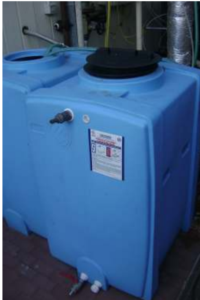
Fig.3.19. Tank di mandata e di ritorno dell'acqua
