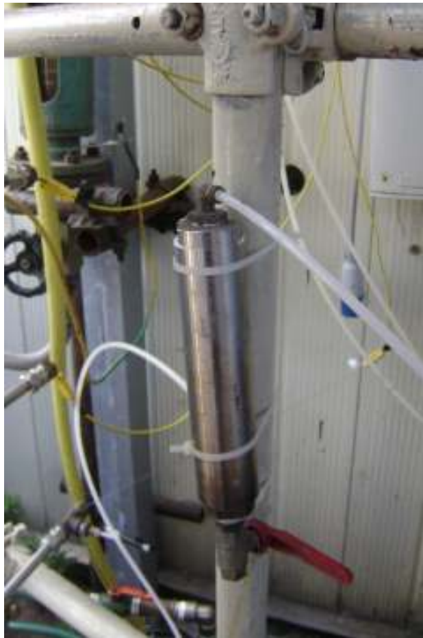
Fig.3.28. Filtro anti-umido per i gas post scrubbing
