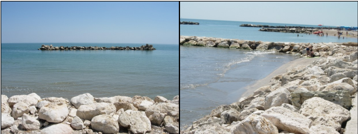
Figura 2.2.2 – Barriere frangiflutti (sinistra) e opere miste con pennelli (destra) lungo le coste oggetto di indagine.
