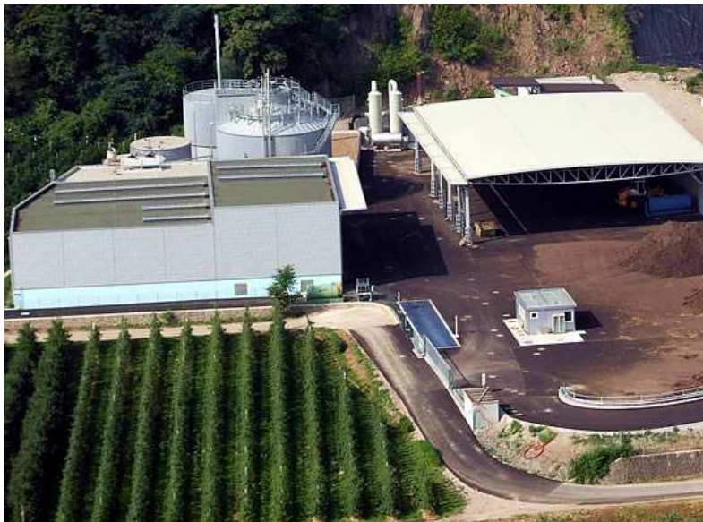
L'impianto di trasformazione dei rifiuti organici "Tisner Au"
