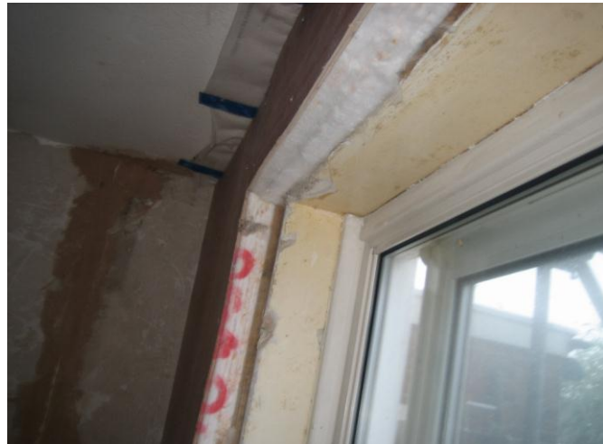
Fig. 5 – Intervento di isolamento interno con l'impiego di Aerogel (foto: ECD Architects).
