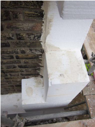
Fig. 4 – Intervento di isolamento a cappotto esterno con EPS (foto: Prewett Bizley Architects).
