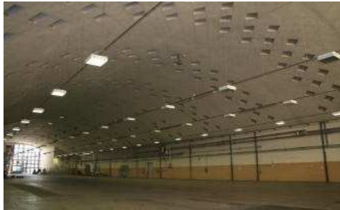
Capannone Miscela Botti. Stato attuale
