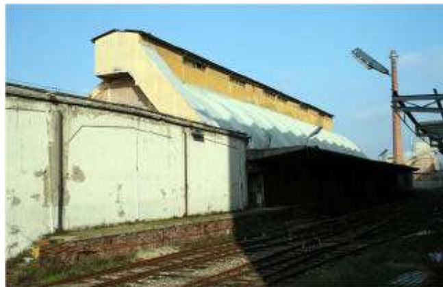
Deposito Sale Comune. Stato attuale
