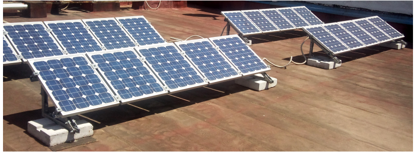
Figura 2.1: Coppia di stringhe da 10 pannelli installate sul tetto del DIBET. Ogni pannello è composto da due sottopannelli da 20 celle ciascuno provvisto di diodo di bypass; la stringa comprende un totale di 400 celle elementari
