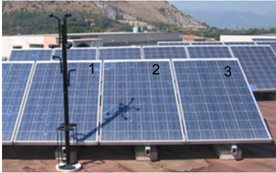
Figura 2.22: Secondo impianto di test: il circuito di monitoraggio è stato installato sulla stringa di 3 pannelli fotovoltaici da 210Wp in silicio policristallino; l'appendiabiti simula fonti comuni di ombreggiamento parziale.
