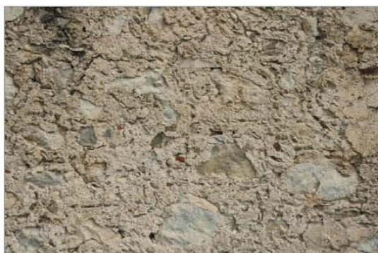
Particolare muratura a raso
