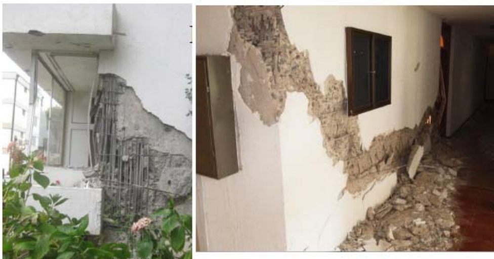
Figura 2.10. Danni sismici all'edificio a Festival.
