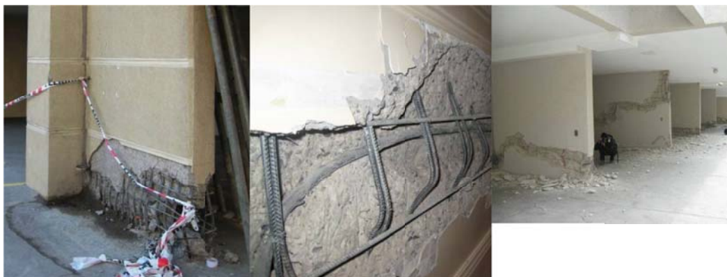
Figura 2.12. Danni su pareti dopo il terremoto del Cile del febbraio 2010.
