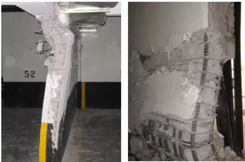
Figura 2.13. Fenomeni di instabilità delle pareti.
