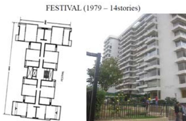
Figura 2.9. Edificio sito a Festival realizzato con struttura a pareti.
