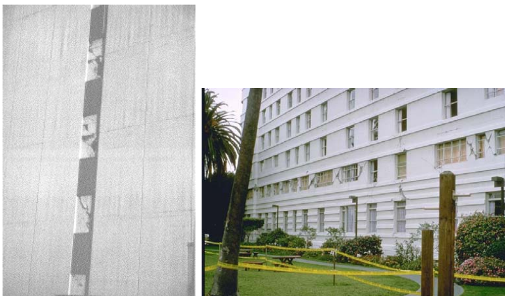
Figura 2.2. Danni all'Ospedale di Santa Monica in California per il terremoto di Northridge del 1994.
