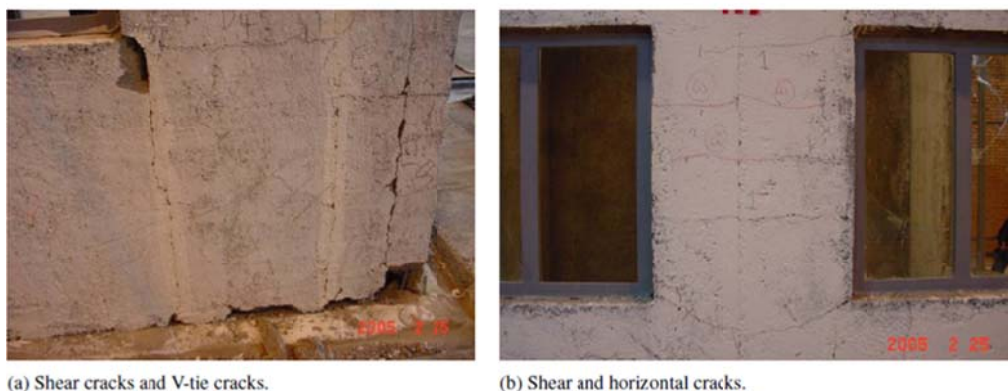
Figura 2.21. Foto delle fessure sulla struttura.
