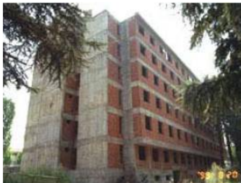
Figura 2.7. Edificio con struttura a pareti in Turchia (WHE Report).
