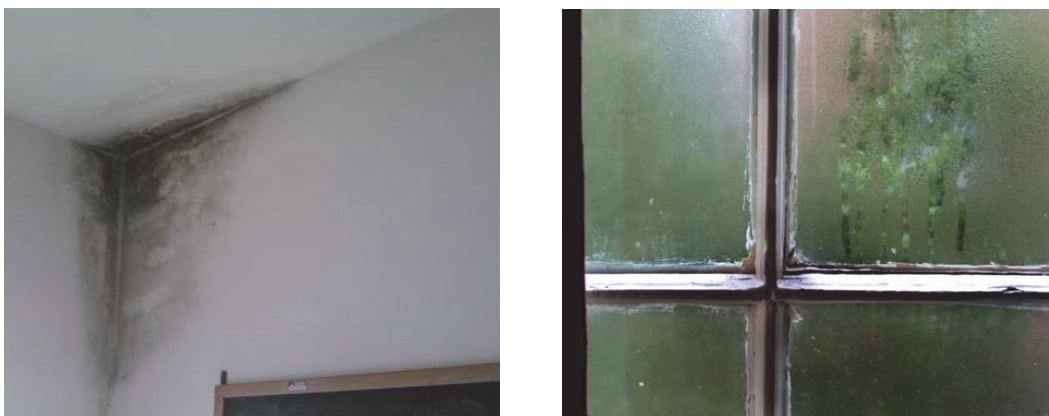
FIG.16 - Formazione di condensa sulla superficie interna (in corrispondenza del nodo tra solaio e parete) e sulla superficie interna vetrata di un infisso;
