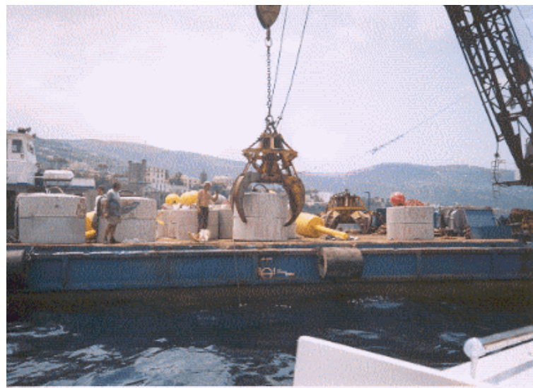
Fig. 15 – Messa a mare dei corpi morti mediante l'impiego di un motopontone
