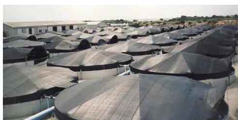
Fig.6 – Allevamento in vasche circolari con coperture
