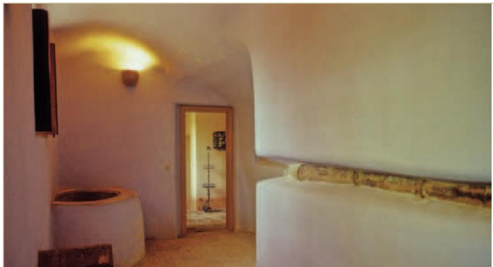
Fig.20-21: La casa dello scirocco a Lentini (Siracusa). Immagine di una botola per lo scambio termico con i qanat sotterranei e immagine di una delle canalizzazioni nelle murature. Fonte: A. Latina, La casa dello scirocco , in "Costruire in laterizio", n.31, 1993
