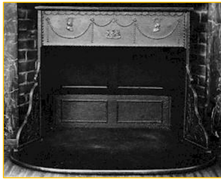
Fig.4 : immagine di un camino di Franklin. Fonte: C. Manzella, I camini moderni tra rischio incendio e arredamento , Brescia, 2006
