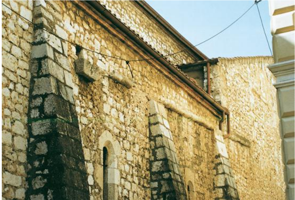
Fig.10: rispetto delle stratificazioni. Duomo di Alatri, la nuova rete di smaltimento insieme alle tracce del vecchio sistema di smaltimento
