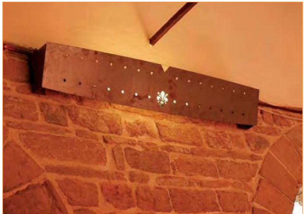
Fig.7: Firenze, Palazzo Vecchio, i corpi illuminanti del camminamento coperto appositamente progettati nei restauri. Fonte: C. Mastrodicasa, Palazzo Vecchio: la sostenibilità in alcuni interventi di restauro . In Città storiche e sostenibilità, Atti del Convegno, Firenze, 17 Marzo 2009.
