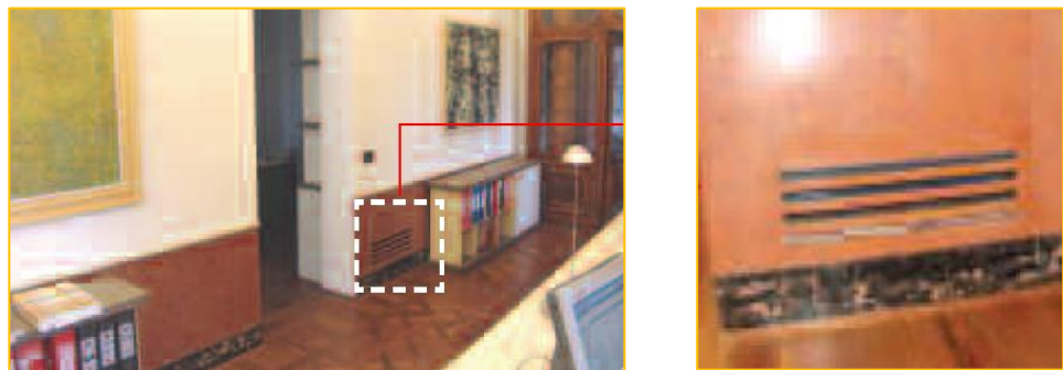
Fig.6-7: sono stati creati appositi elementi di arredo e finitura destinati a mascherare i ventilconvettori
