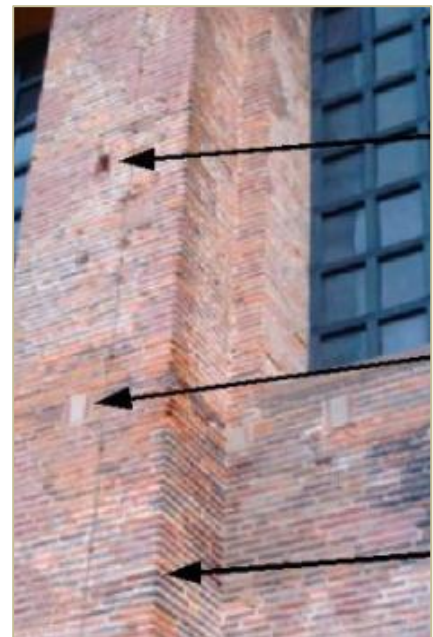
Fig.14: la basilica di Costantino a Treviri; fig.15: tracce del praefurnium; fig.16: tracce dei camini per il tiraggio dei fumi. Fonte: http://www.treveris.com
