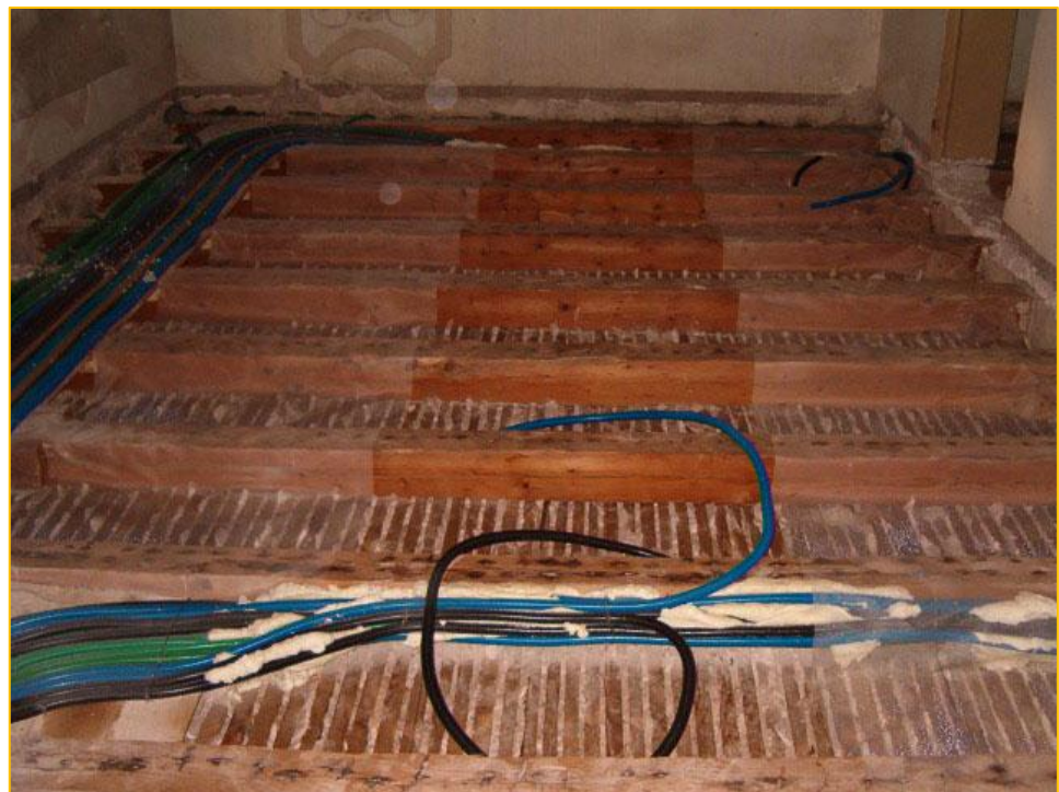
Fig. 5: la progettazione ha previsto con accuratezza i percorsi delle canalizzazioni dei vari impianti, sfruttando, come in questo caso, gli spazi tra gli interassi dei solai consolidati Fonte: Archivio Studio Feiffer
