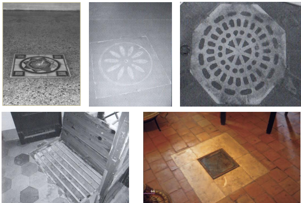
Fig.7-8-9: immagini di analoghe bocchette di immissione nei pavimenti rispettivamente di Palazzo Corsini, villa Corsini e a palazzo Pitti a Firenze.
