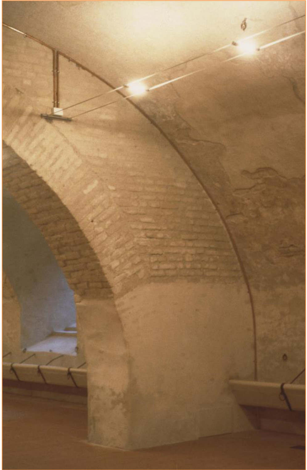
Fig.11: V. Prina, Restauro delle Scuderie del Castello Visconteo, Pavia, 2000-2002. L'intervento impiantistico utilizza cavi elettrici ad isolamento minerale a vista e illuminazione di scarso impatto. Fonte: archivio on line dell'Ordine degli Architetti, Pianificatori, Paesaggisti e Conservatori della provincia di Pavia)
