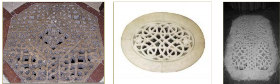
Fig.4-5-6: immagini delle griglie di immissione nei pavimenti delle ville di Costozza (Vi) Fonte: Balocco C., Farneti F., Minutoli G., I sistemi di ventilazione naturale negli edifici storici , Firenze, 2009
