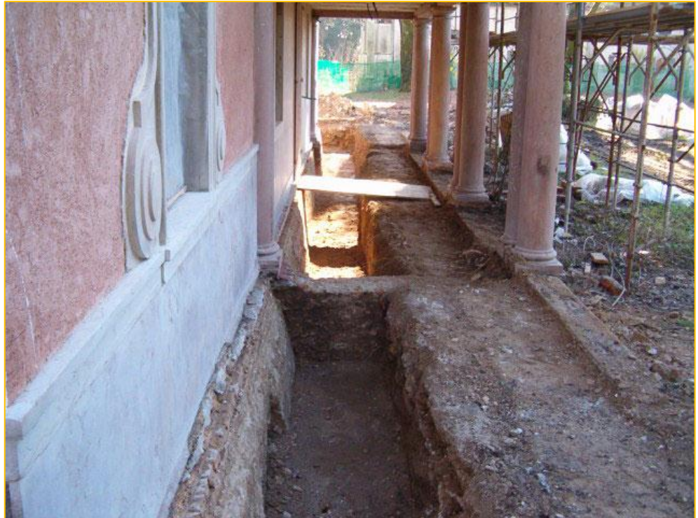
Fig.3: l'anello tecnologico perimetrale che accoglie gli impianti del piano terra che poi rientrano nei punti stabiliti. Un sistema analogo è stato utilizzato per il sottotetto, nel quale le canalizzazioni passano all'estradosso della copertura sotto al manto di tegole in particolari alloggiamenti. Fonte: Archivio Studio Feiffer
