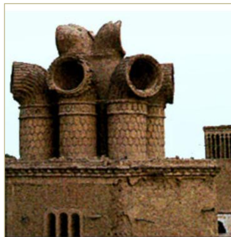
Fig.4-5-6: Immagini di torri del vento, con le bocche orientate in precise direzioni Fonte: Guido Moretti, Abitare il desert, o Bologna 2007
