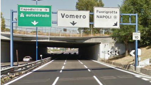
Portale di Fuorigrotta – Km 9+684
