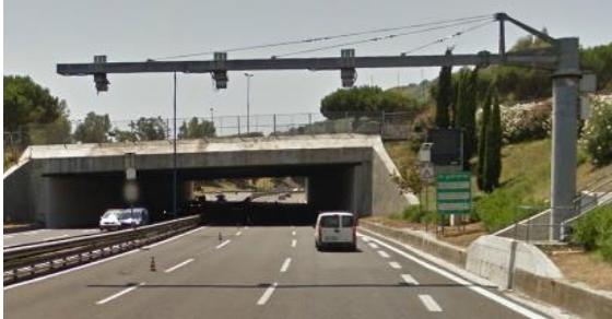
Portale di Fuorigrotta – Km 9+986
