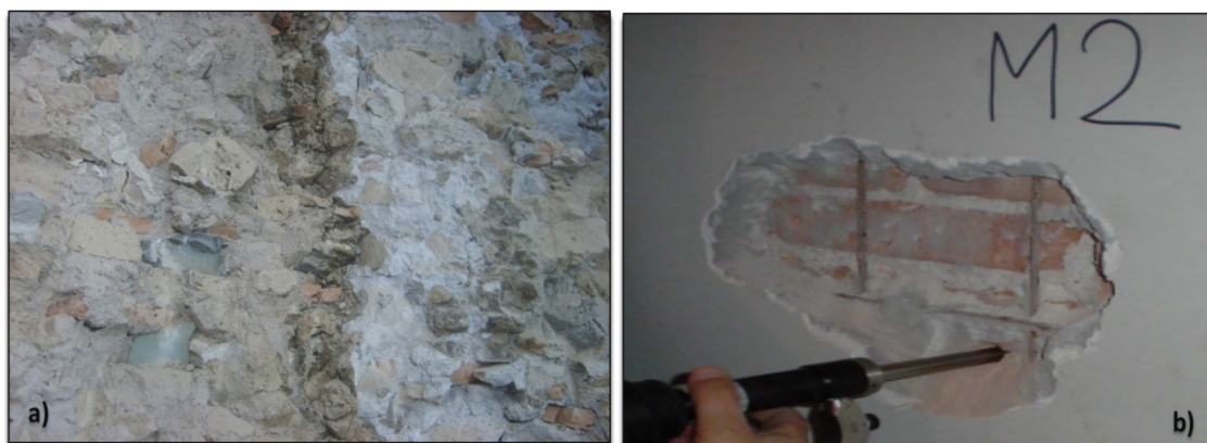
Figura 3.8: Particolare muratura: a) piano terra; b) primo e secondo piano.
