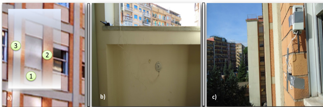
Figura 3.30: Misura con termoflussimetro: a) schema della parete esterna; b) posizionamento sensori lato interno del sottofinestra; c) posizionamento sensori lato esterno parete con rifinitura in mattoni.
