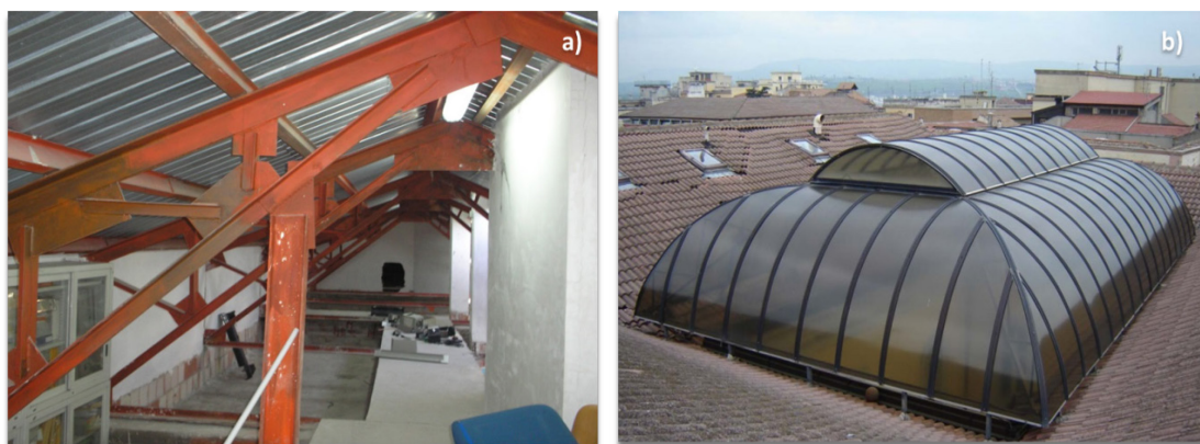
Figura 3.9: Solaio: a) particolare della copertura a falde; b) particolare della copertura del cortile.
