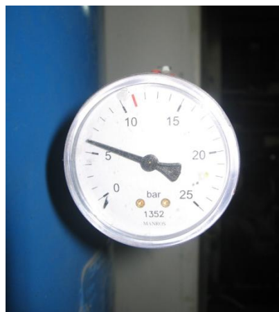
Fig. 2.29 – Dettaglio del manometro. Sono visibili le pressioni di esercizio (fino alla barretta rossa) e le pressioni critiche per l'impianto (fondo scala = 25 bar).
