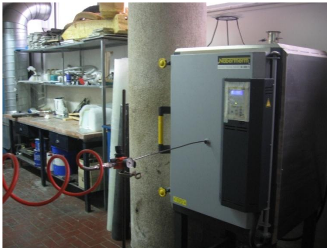
Fig. 3.16 – Impianto inserito all'interno del forno: si notino i condotti flessibili, il condotto rigido e la valvola con riduttore di pressione.
