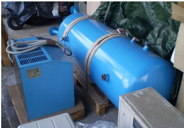
Fig. 2.27 – Compressore in fase di montaggio. Sono ben visibili la scatola della turbomacchina a sinistra e il serbatoio di accumulo a destra.
