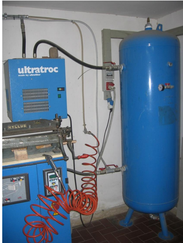
Fig. 2.28 – Compressore collegato al serbatoio. Sono distinguibili il manometro e i condotti flessibili di distribuzione del fluido all'utenza.
