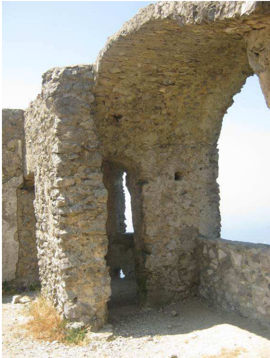
Figura 66 Gli ambienti voltati ed il vano di collegamento esistente tra di loro (Foto F. Comes 2012)
