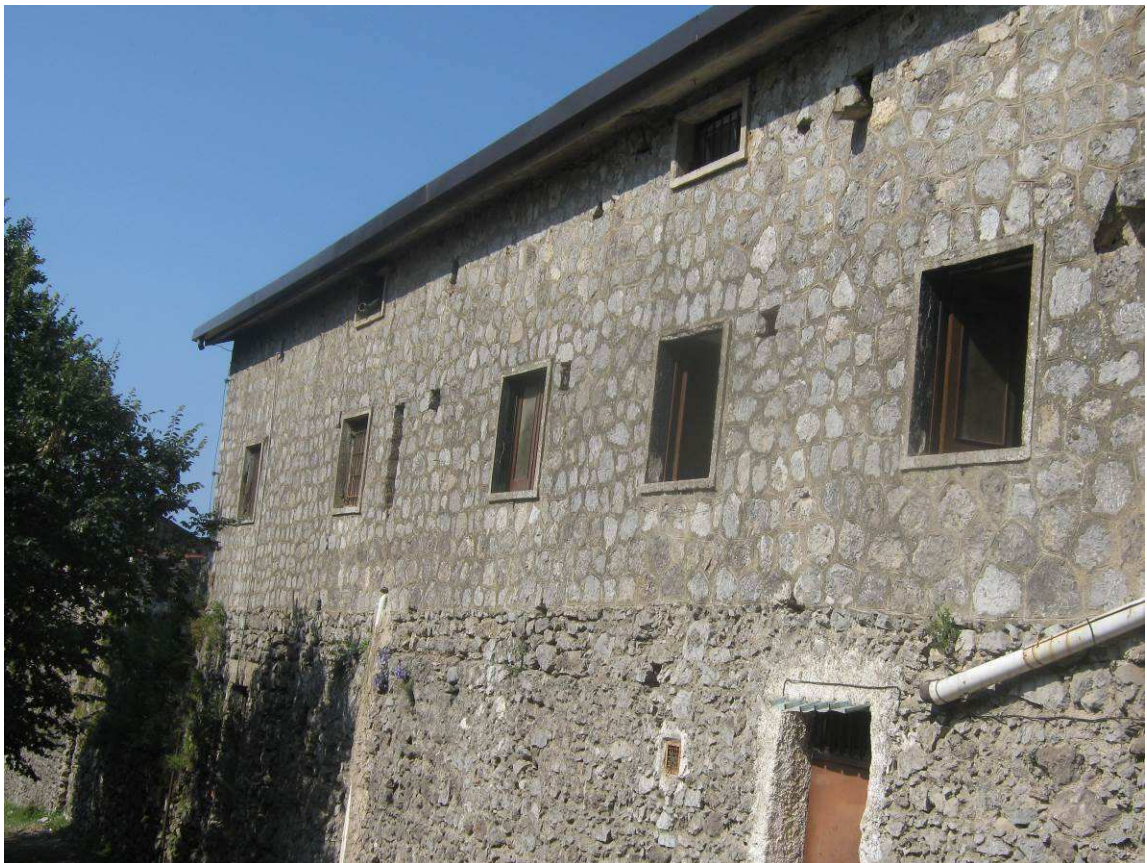
Figura 2 L'Eremo della Madonna dell'Avvocata in Maiori. Il prospetto longitudinale della foresteria che dà verso l'esterno: evidente le differenti caratteristiche costruttive tra questa ed il muro di cinta su cui si innesta. Alla disordinata e caotica disposizione di irregolari conci di pietra nella parte inferiore, si oppone la regolarità costruttiva della parte superiore. (Foto F. Comes 2012)
