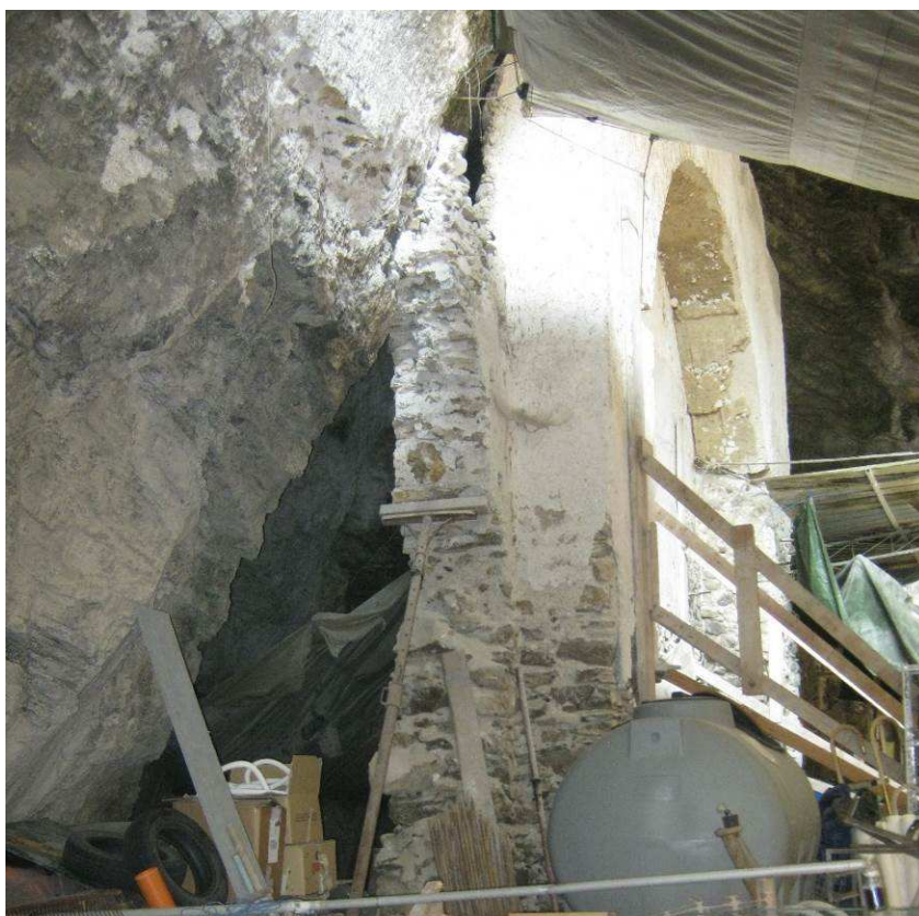
Figura 16 La Grotta dell’Annunziata in Minori. La parete dell’antica chiesa è realizzata a filo con la superficie rocciosa retrostante distanziandosi da essa solo alla base (Foto F. Comes 2013)
