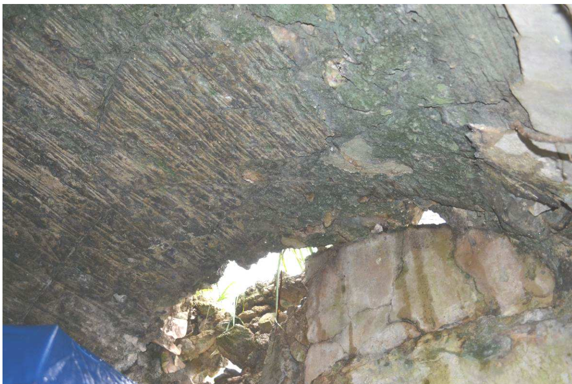
Figura 3 L'abbazia di San Pietro a Crapolla. L'interno del locale posto a nord-ovest, in origine probabilmente una cisterna. Particolare della volta realizzata con la tecnica a incannucciata (Foto F. Comes 2012)
