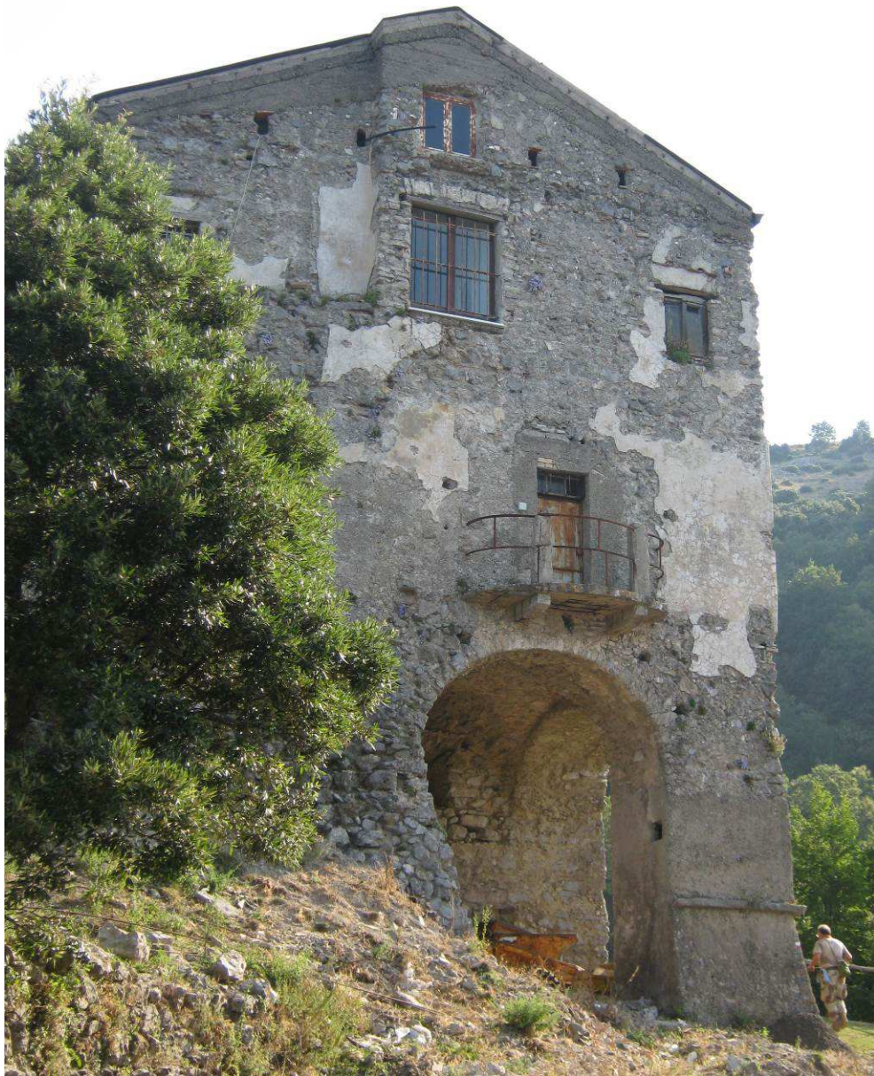
Figura 63 Il prospetto del romitorio che dà verso il mare: evidente la facciata a capanna impostata su un sistema voltato. Degno di nota è il piccolo balcone, dalla forma bombata. Si possono evidenziare, infine, alcuni lacerti d'intonaco (Foto F. Comes 2012)
