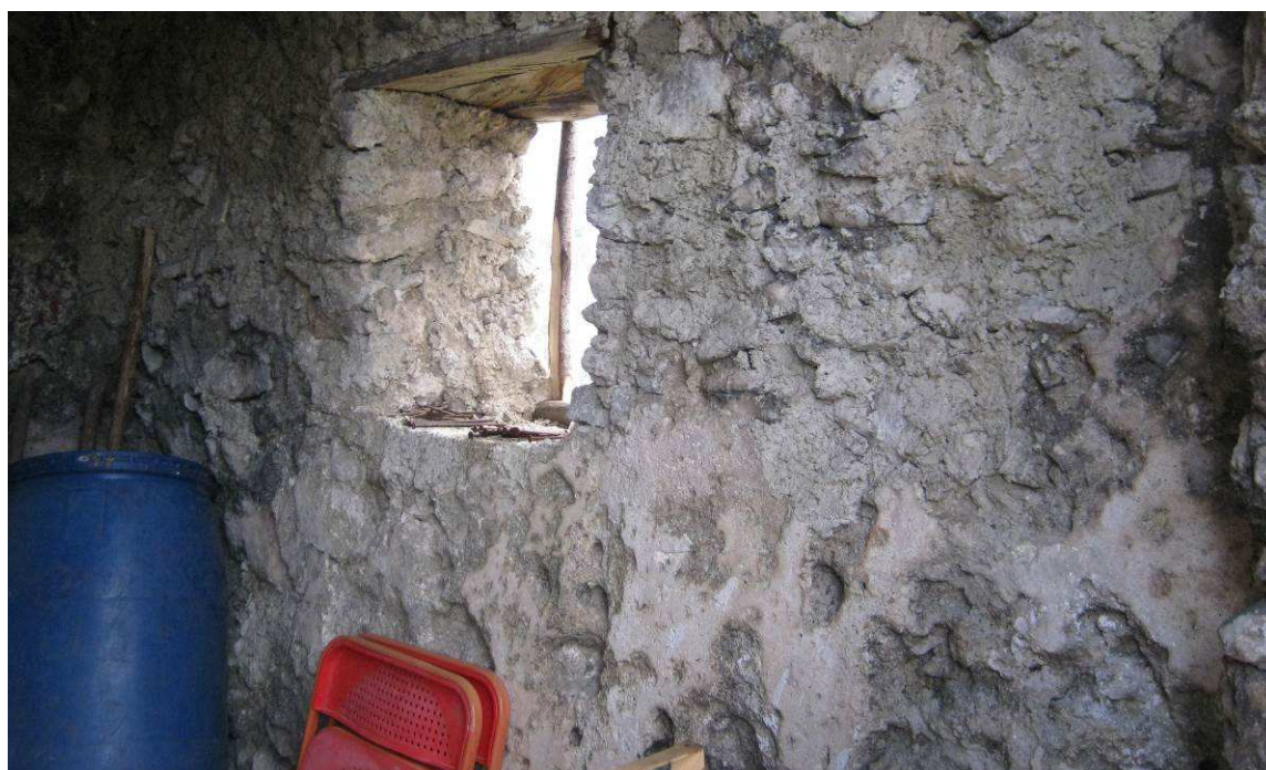
Figura 98 L'interno dell'ambiente minore. Evidente la presenza di alcuni lacerti di intonaco tinteggiato (Foto F. Comes 2011)
