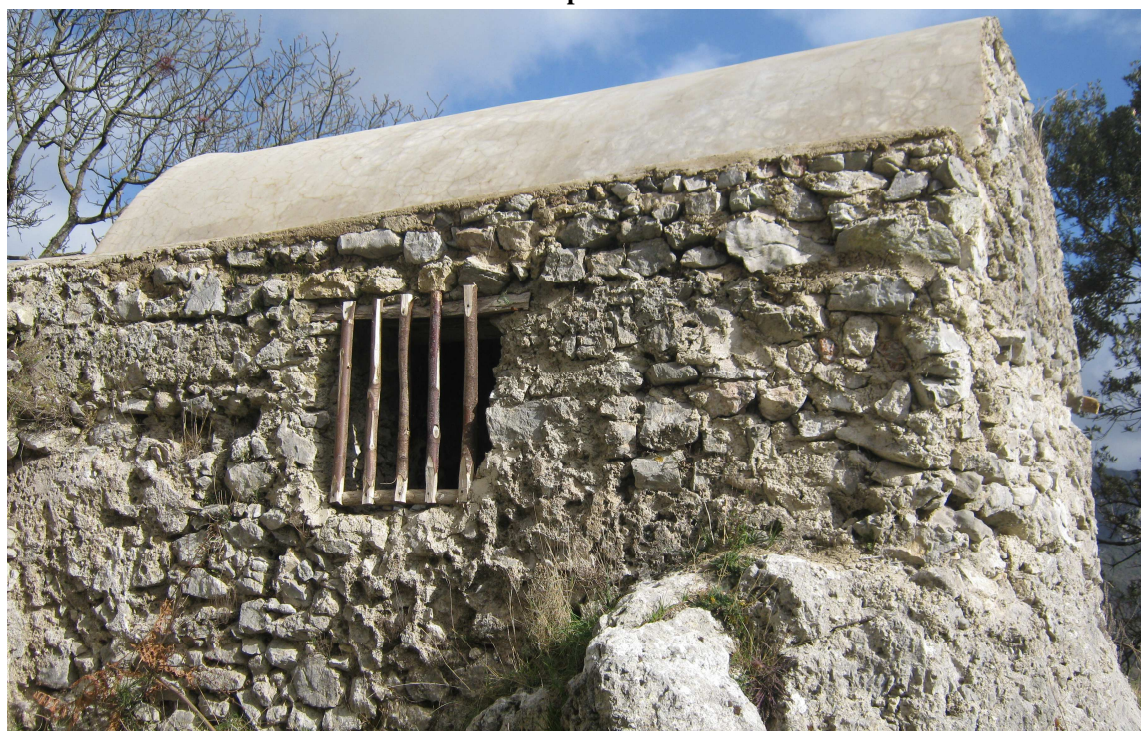
Figura 100 La fabbrica minore, così come appare oggi (Foto F. Comes 2011)
