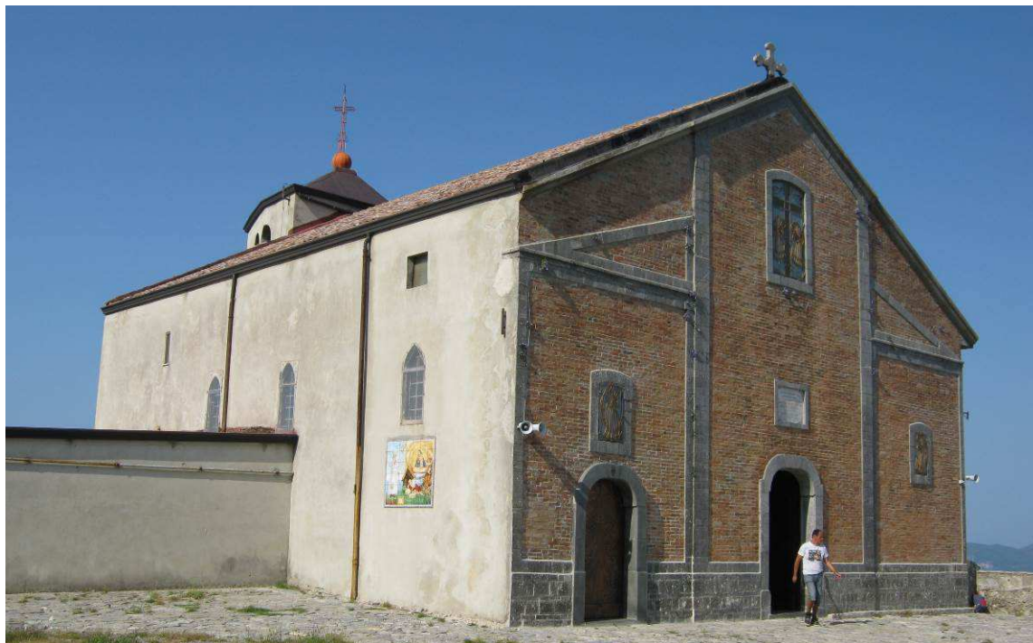
Figura 55 La facciata della Chiesa ed il prospetto laterale, l'unico intonacata, allo stato attuale. Come evidente dall'immagine, la facciata è rivestita da mattoncini rossi ed attraversata da nervature in pietra chiara che ne sottolineano le caratteristiche compositive e ne valorizzano i singoli elementi (Foto F. Comes 2012)
