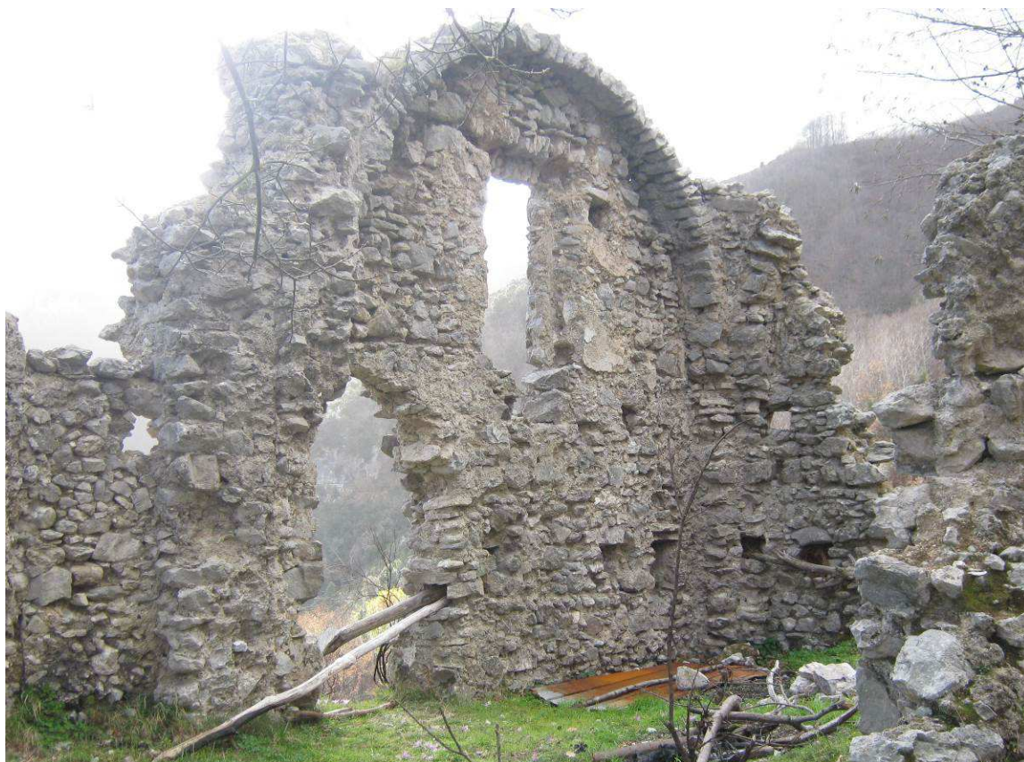
Figura 96 La maggiore delle due fabbriche. Particolarmente interessante il prospetto che dà sul fondovalle, caratterizzato da due aperture impostate su due diverse altezze ed archivoltato. Dall'osservazione condotta su uno dei due cantonali, è stato possibile ipotizzare l'esistenza di un'originaria volta di copertura dell'intera fabbrica (Foto F. Comes 2011)
