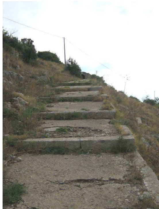
Figura 74 La scalinata in cemento che conduce sino alla sommità (Foto F. Comes 2012)
