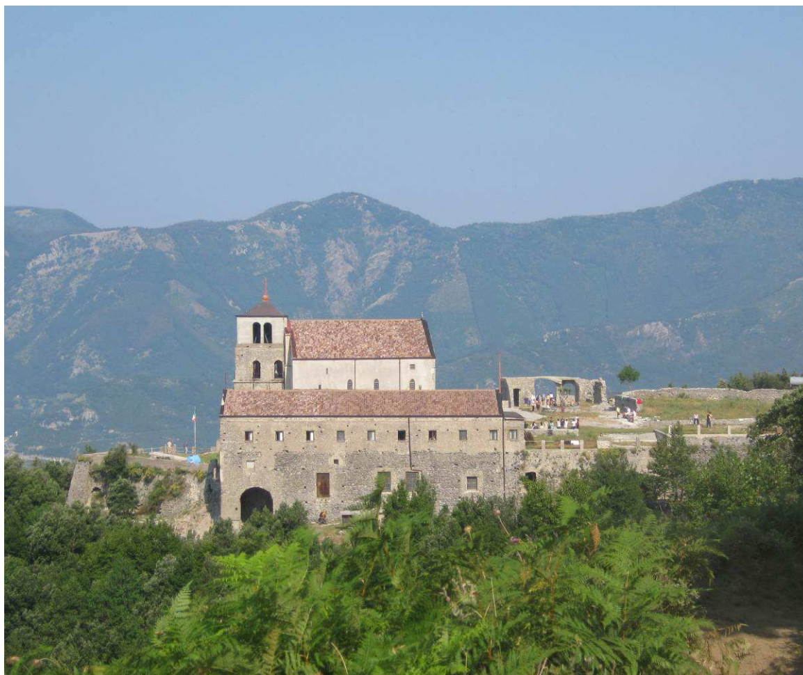
Figura 61 L'Eremo della Madonna dell'Avvocata visto da un'altura vicina. In primo piano il romitorio, innestato sul muro di cinta, si presenta come un lungo edificio che "regolarizza" in altezza il dislivello a ridosso del quale sorge (Foto F. Comes 2012)
