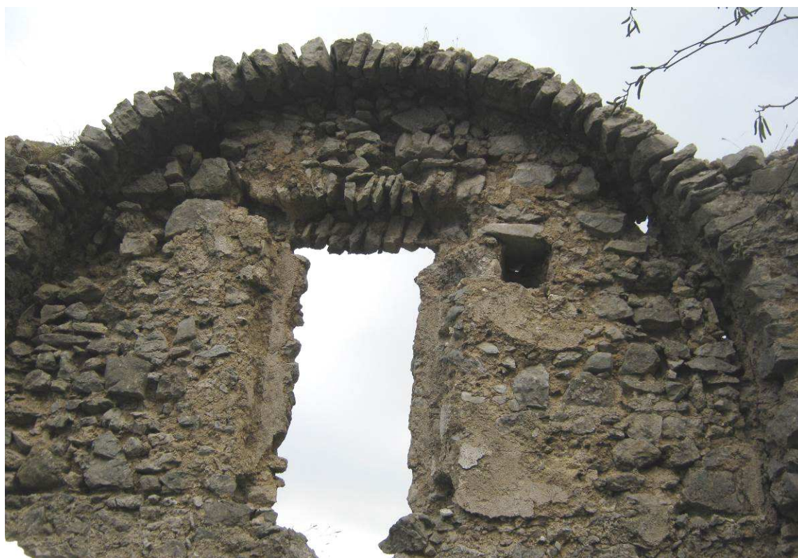
Figura 1 L'Eremo di Santa Caterina in Tramonti. Evidente l'uso di elementi lapidei di pezzature tra loro assai differenti (Foto F. Comes 2011)
