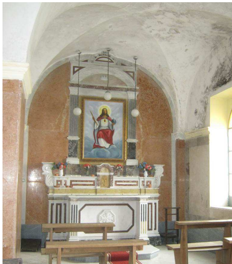
Figura 85 L'interno della Chiesa, oggi ad unica navata. La presenza di due volte a crociera impostate su pilastri ed in asse con quelle della sala vicina, rivelano la continuità architettonico-compositiva di due ambienti originariamente nati per asservire alla medesima funzione. Sull'altare, troneggia l'immagine del Cristo Liberatore (Foto F. Comes 2012)
