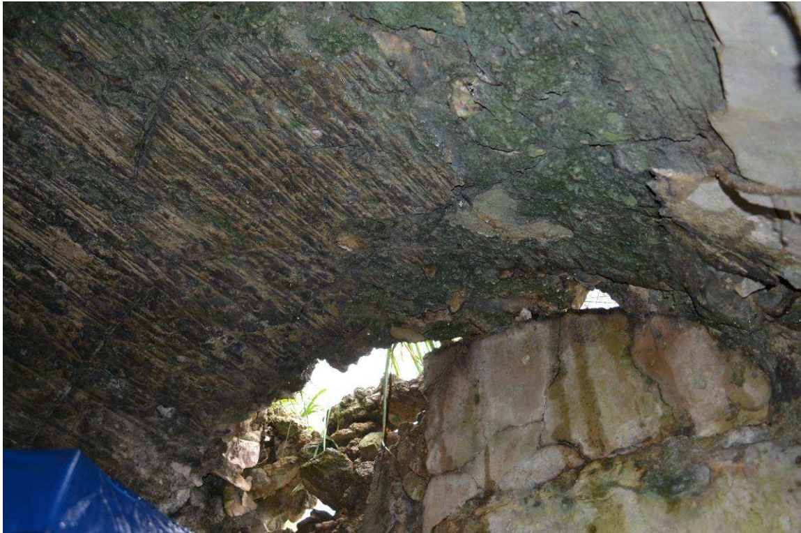
Figura 36 L'interno del locale posto a nord-ovest, in origine probabilmente una cisterna. Particolare è la volta a botte di copertura: questa presenta con evidenza all'intradosso i segni dell'impronta dell'incannucciata utilizzata quale cassaforma per la realizzazione della volta stessa (Foto F. Comes 2013)
