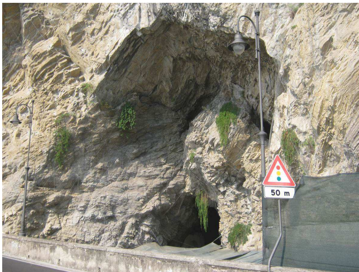
Figura 126 L'antro dell'Annunziata. Dall'esterno si riesce ad intravedere solo una piccola porzione degli sparuti ruderi (Foto F. Comes 2013)
