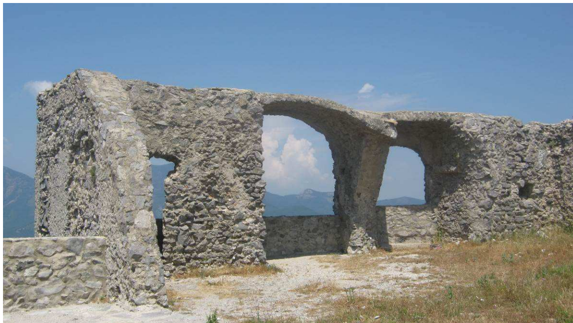
Figura 65 Ciò che rimane dell'antica foresteria, originariamente ubicata in continuità con la Chiesa, sul lato opposto del recinto. I ruderi testimoniano dell'esistenza di una serie di piccoli ambienti voltati che si aprono sul panorama a ridosso del precipizio. Evidente, da questa foto l'irregolarità degli apparecchi murari (Foto F. Comes 2012)
