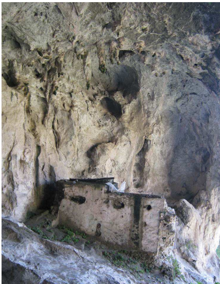
Figura 135 I locali posti al sud e separati dallo spazio liturgico da alcuni gradini ricavati nella roccia. Una seconda gradinata in muratura, addossata all'antro roccioso, costeggia quello più arretrato, probabilmente un tempo il campanile, data proprio la presenza della scala che si interrompe sulla copertura (Foto F. Comes 2013)
