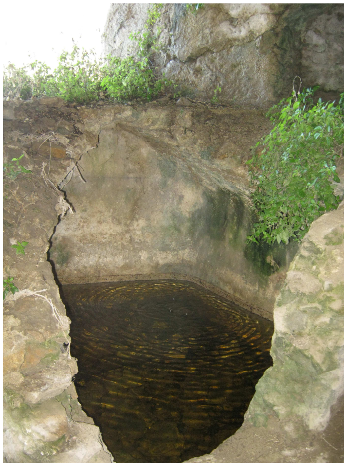
Figura 133 Il vano-cisterna, interamente costruito, si caratterizza per una copertura voltata all'intradosso e per un piano orizzontale all'estradosso (Foto F. Comes 2013)
