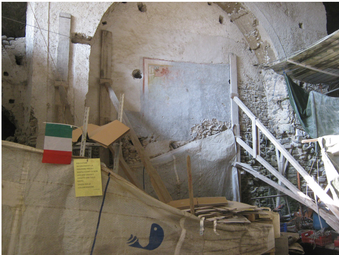
Figura 9 La struttura ad arco ancora esistente: rivestita in gran parte da uno spesso strato di intonaco a calce, è sostenuta da una serie di puntelli in legno (Foto F. Comes 2013)
