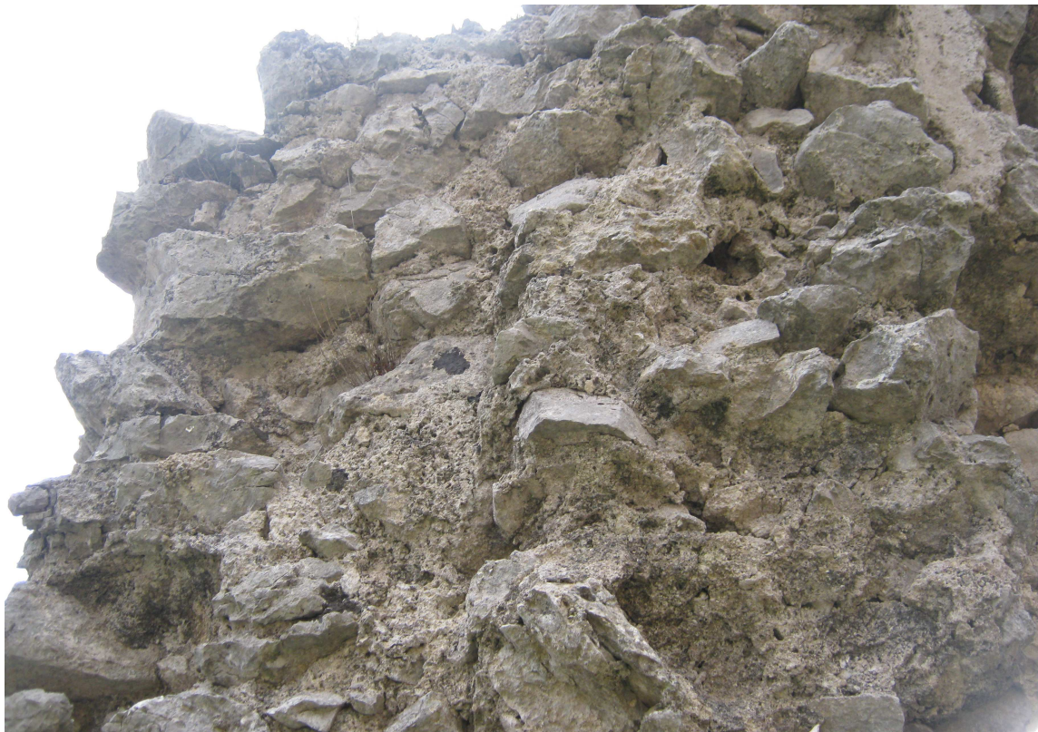
Figura 101 Particolare della muratura. Evidente, in questa immagine, l'uso di bozze calcaree fortemente irregolari assemblate con malta di calce (Foto F. Comes 2011)
