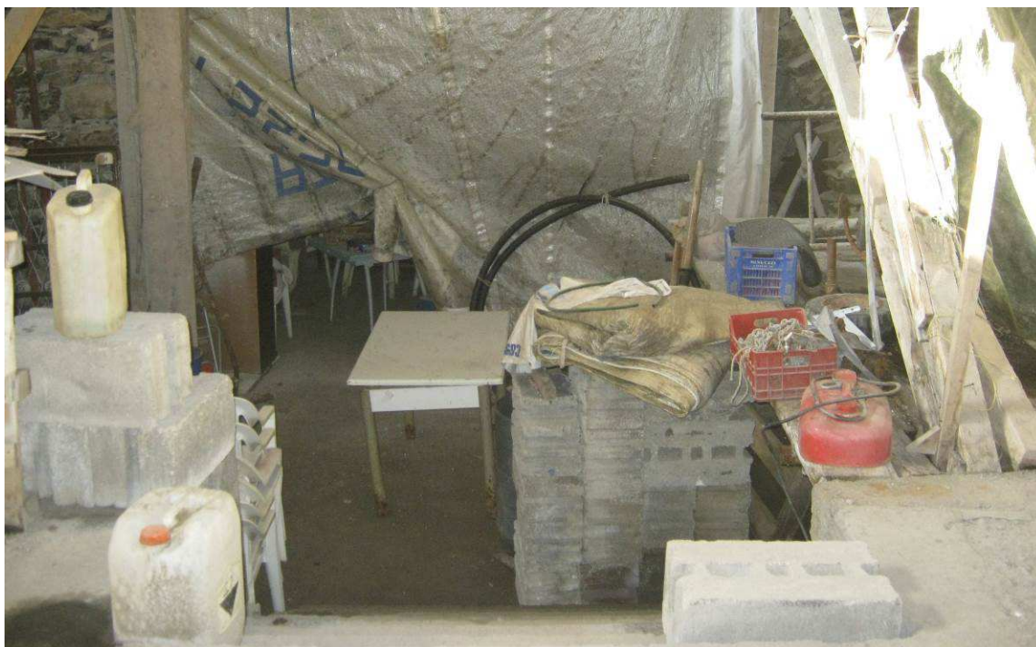
Figura 5 L'arco che introduce al piccolo ambiente a ridosso della roccia, anch'esso adibito a deposito. Un massetto in cemento riveste il piano di calpestio, cancellando ogni traccia del piccolo laghetto d'acqua (Foto F. Comes 2013)
