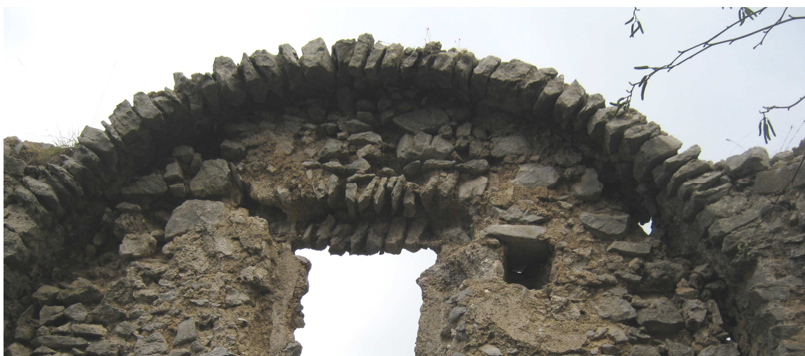
Figura 102 L'ambiente maggiore, particolare della struttura ad arco. Evidente la maggiore regolarità delle bozze di pietra che costituiscono la superficie arcuata (Foto F. Comes 2011)
