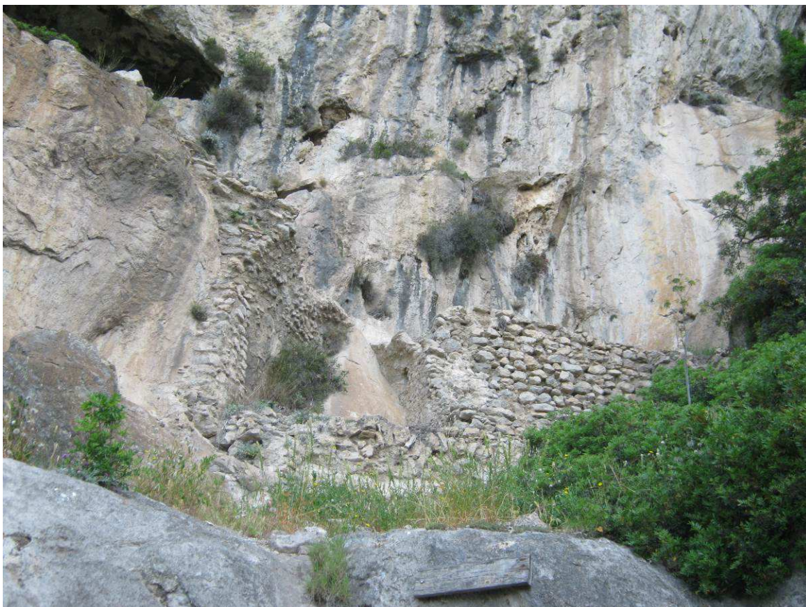
Figura 108 L'antica gradonata di accesso all'Eremo. Le due strutture murarie, ancora nel 2001, erano raccordate da un piccolo elemento voltato (Foto F. Comes 2011)
