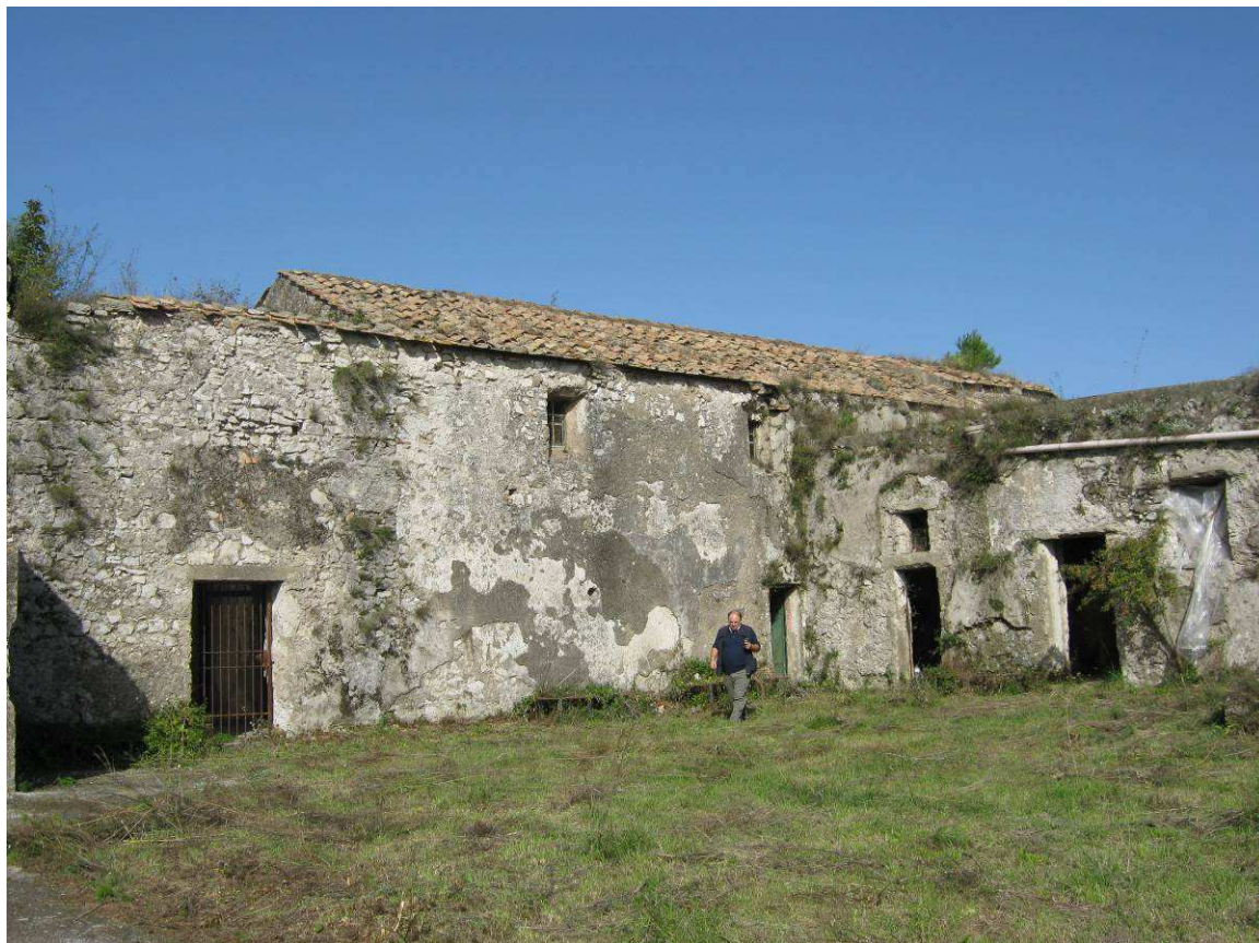
Figura 21 I prospetti prospicienti la corte (Foto F. Comes 2010)
