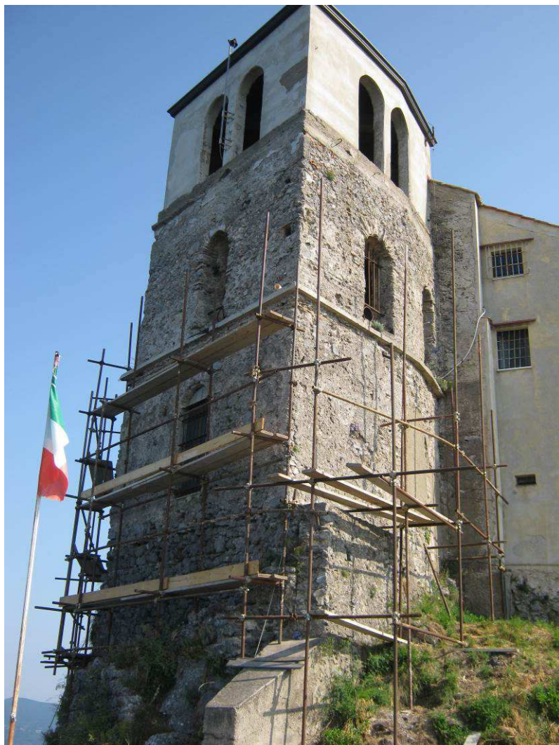
Figura 69 Il campanile parzialmente intonacato. Come si può constatare da quest'immagine, i lavori di intonacatura non sono ancora terminati. In basso, sulla destra, è visibile una delle due aperture tompagnate (Foto F. Comes 2012)
