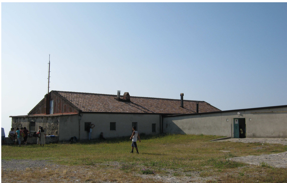
Figura 62 Il fronte del romitorio che dà verso la Chiesa e parte del corridoio di collegamento a questa: esso rappresenta l'unica porzione dell'edificio completamente intonacato (Foto F. Comes 2012)
