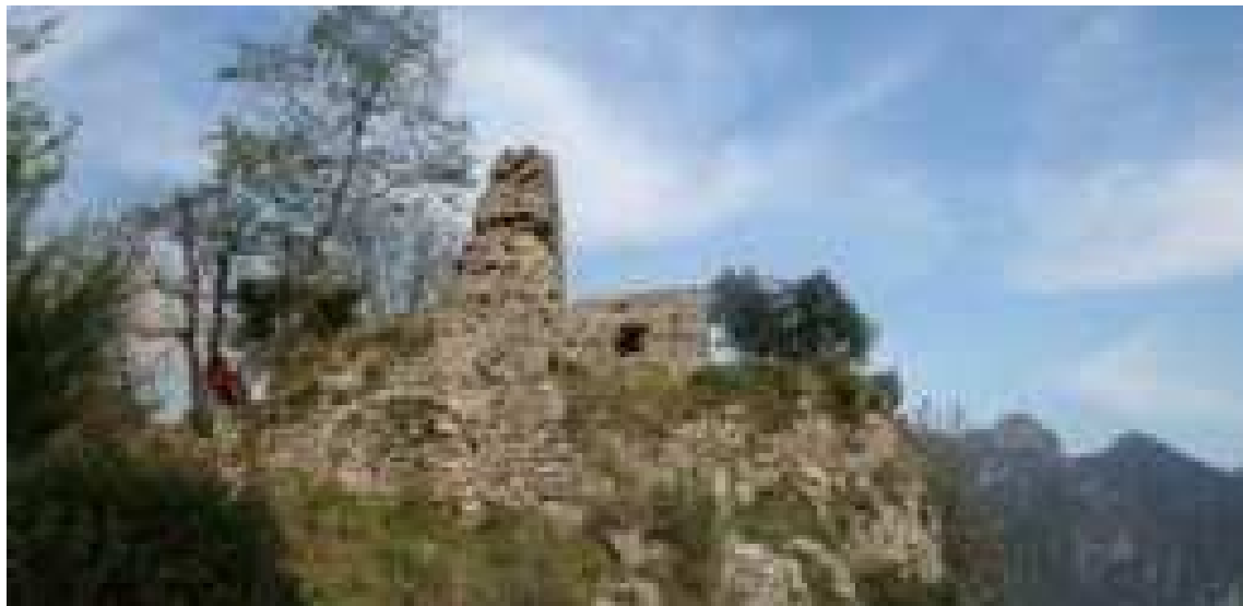
Figura 99 Nonostante la scarsa qualità dell'immagine, la stessa, realizzata prima dell'anno 2011, testimonia lo stato di conservazione dell'Eremo prima dell'intervento dei volontari: la volta di copertura dell'ambiente minore è ancora visibile nella sua originaria fattezze, così come l'apertura laterale è priva dell'infitto a grate di legno che oggi la caratterizza. Immagine tratta da www.campaniacrbc.it
