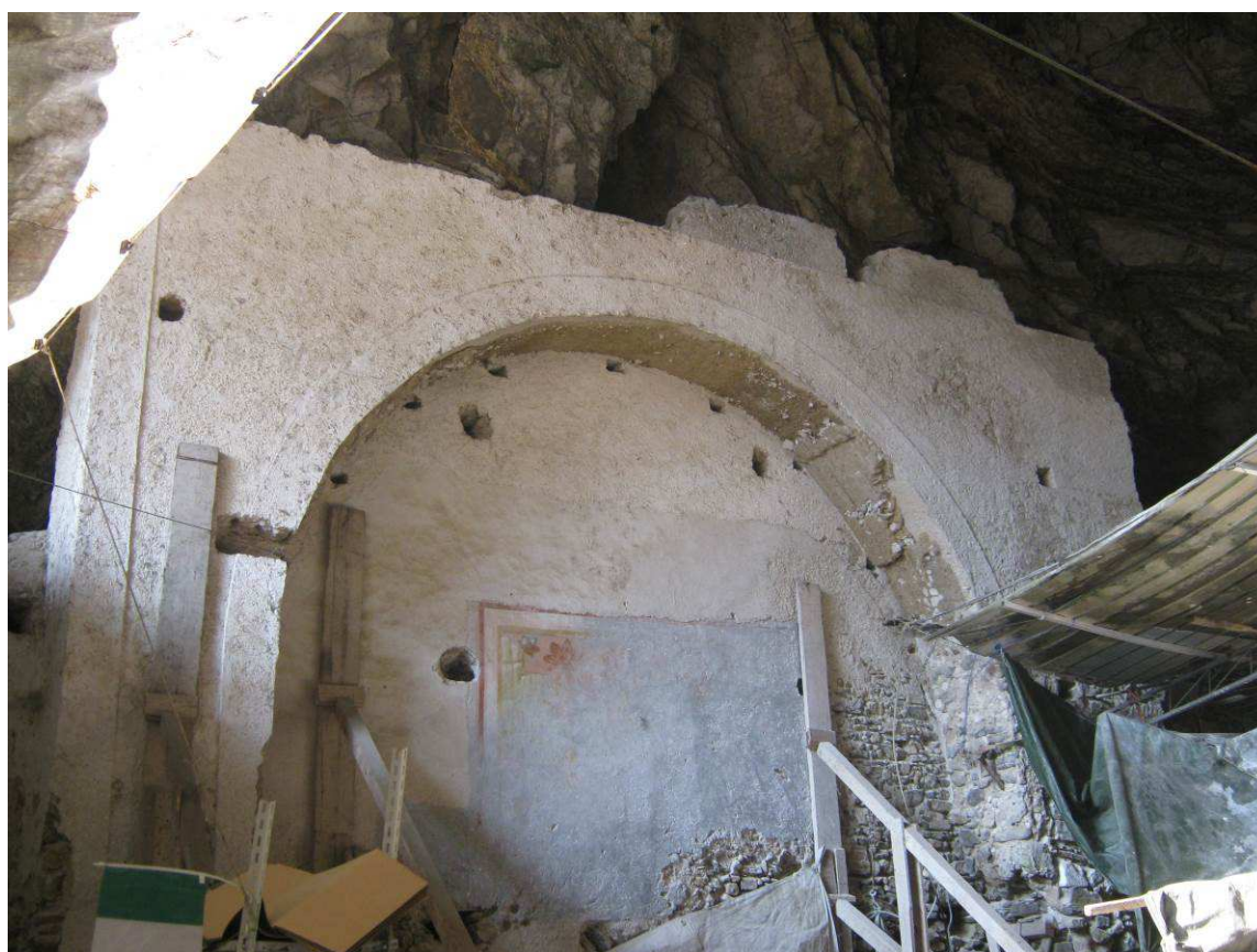
Figura 4 L'affresco come appare oggi, occultato da uno spesso strato di intonaco a calce (Foto F. Comes 2013)
