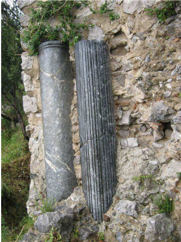
Figura 29 Due delle colonne di reimpiego inglobate nel prospetto a sud della cappella (Foto F. Comes 2013)
