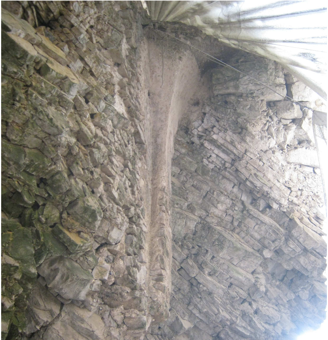
Figura 12 Il lacerto di muratura intonacata incastonato nella roccia, segno della presenza, all'interno della grotta, di un'originaria seconda struttura (Foto F. Comes 2013)
