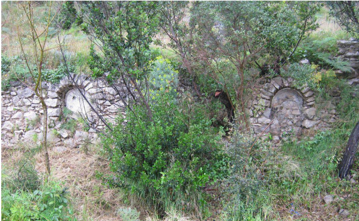
Figura 35 Le nicchie poste lungo il muro a nord del claustrum , Evidente la presenza di alcune tracce d’intonaco tinteggiato. Da sottolineare, inoltre, l’uso di conci calcarei più piccoli e regolari a partire dalle imposte degli archi (Foto F. Comes 2013)
