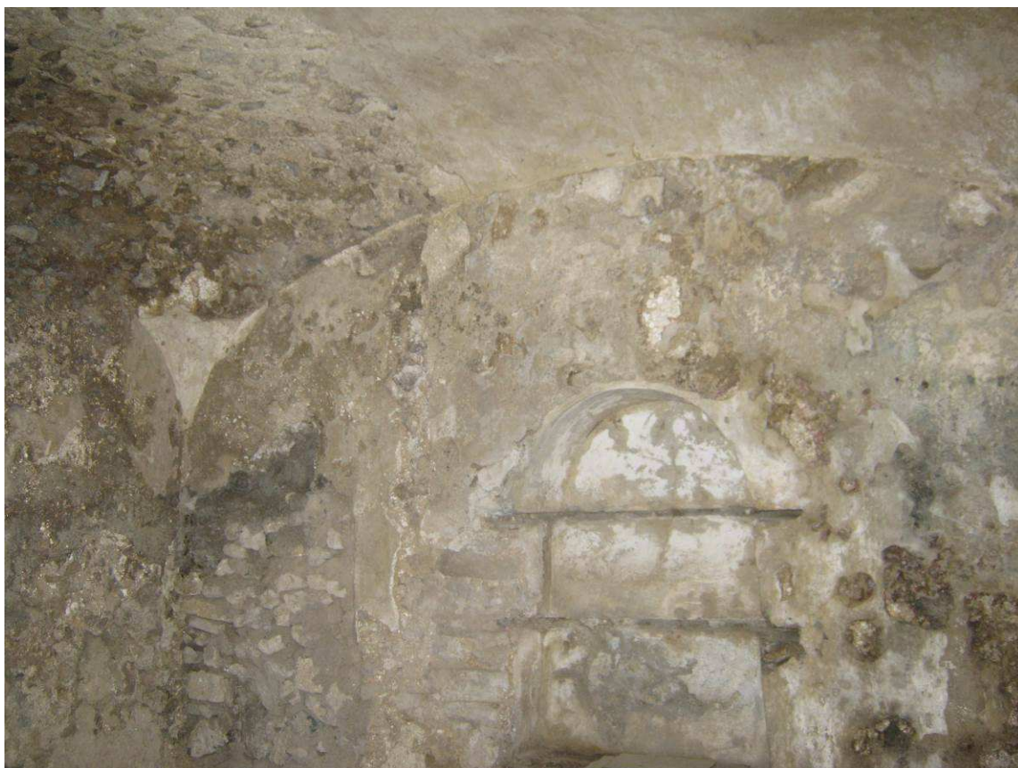
Figura 81 Uno degli ambienti voltati che costituiscono il nucleo originario dell'Eremo. Nella foto, evidente è la presenza di alcuni frammenti d'intonaco, ancorché fortemente ammalorati, ed una delle nicchie presenti anche negli altri vani (Foto F. Comes 2012)
