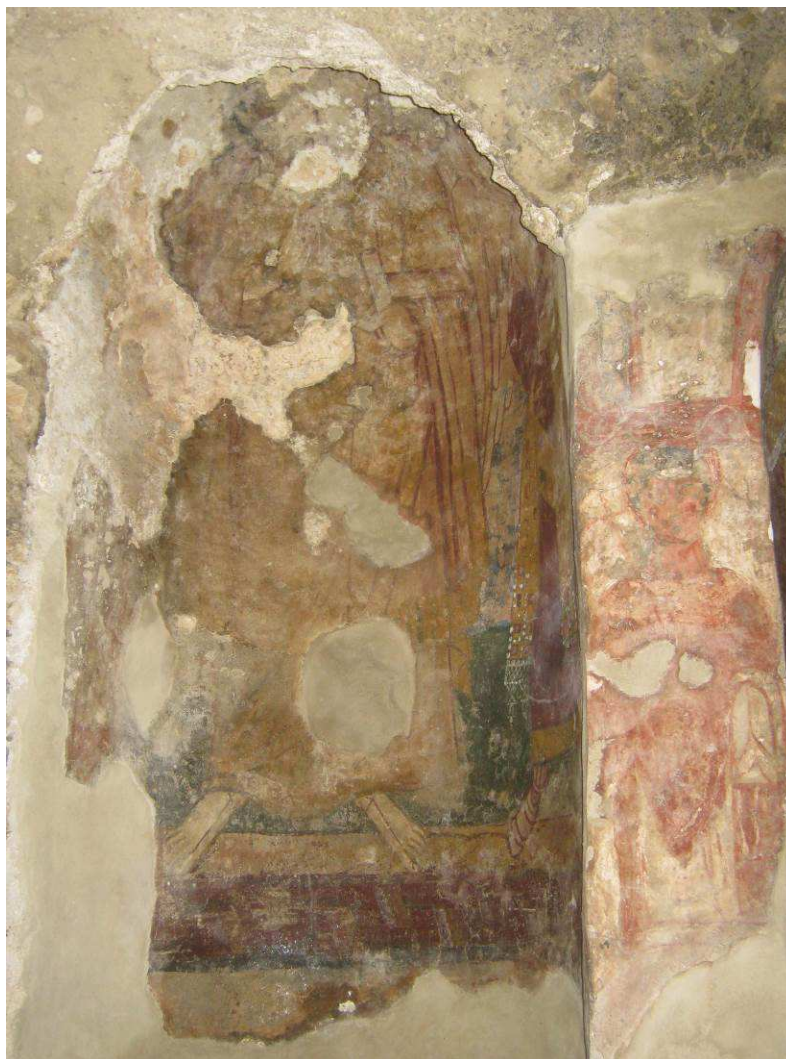
Figura 4 L'abside centrale, con la raffigurazione del Cristo benedicente e gli arcangeli. Da notare la striscia rossa su cui si distinguono alcuni segni bianchi, parti, secondo R. P. Bergman, di un'originaria iscrizione. Nella foto si vede anche la figura rappresentata sul muro tra le due absidi, probabilmente una santa, indossa una tunica bianca ed un mantello rosso (Foto F. Comes 2011)
