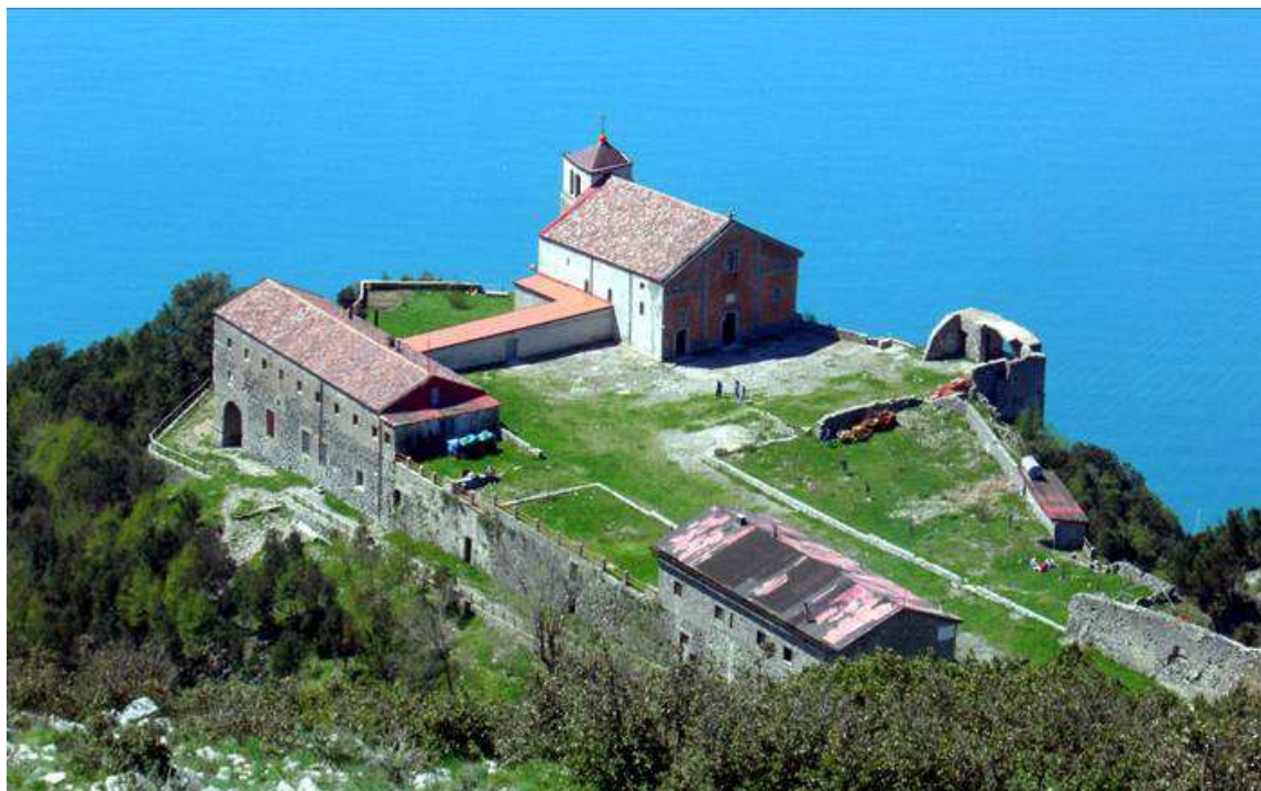
Figura 46 L'Eremo della Madonna dell'Avvocata in una foto dall'alto di alcuni anni fa. Evidente l'idea architettonica del recinto che abbraccia i vari dislivelli sfruttando la doppia altezza per la formazione di vani seminterrati adibiti a cisterne e depositi. Allo stato attuale, il pianoro antistante la Chiesa è rivestito in pietra e su di esso è stata realizzata un'aiuola a pianta circolare. Entrambi gli interventi sono stati realizzati attraverso l'opera di volontari e fedeli. Immagine tratta da www.costiera-amalfitana.com
