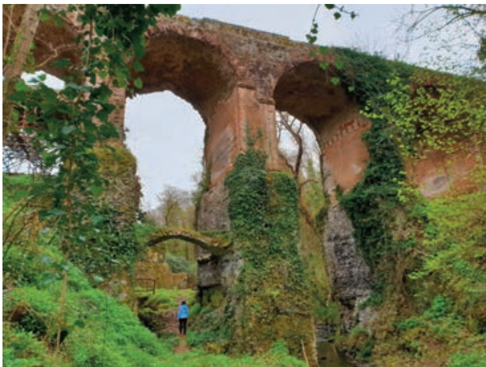
Fig. 7. Ponte Ronaco (Aurunco), foto di Giuseppe Di Caprio.
