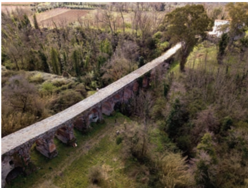
Fig. 8. Ponte Ronaco (Aurunco), foto di Giuseppe Di Caprio.
