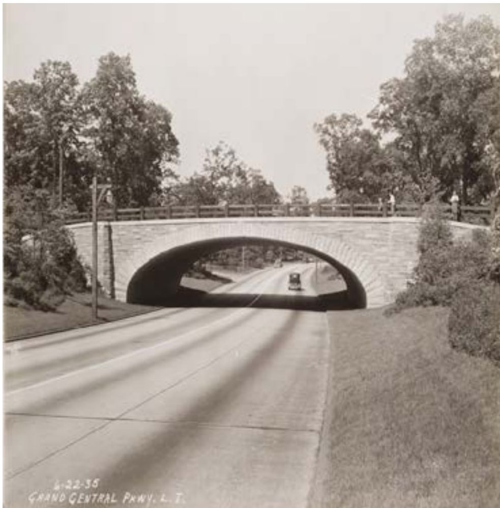
Ponte lungo il percorso delle Long Island Parkways , l'immagine mostra l'altezza ridotta dell'intradosso, realizzato secondo le indicazioni di Robert Moses, foto dell'Archivio Municipale di New York.
