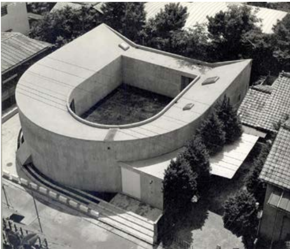
Foto delle coperture della White U House, Toyo Ito, Tokio, 1976
